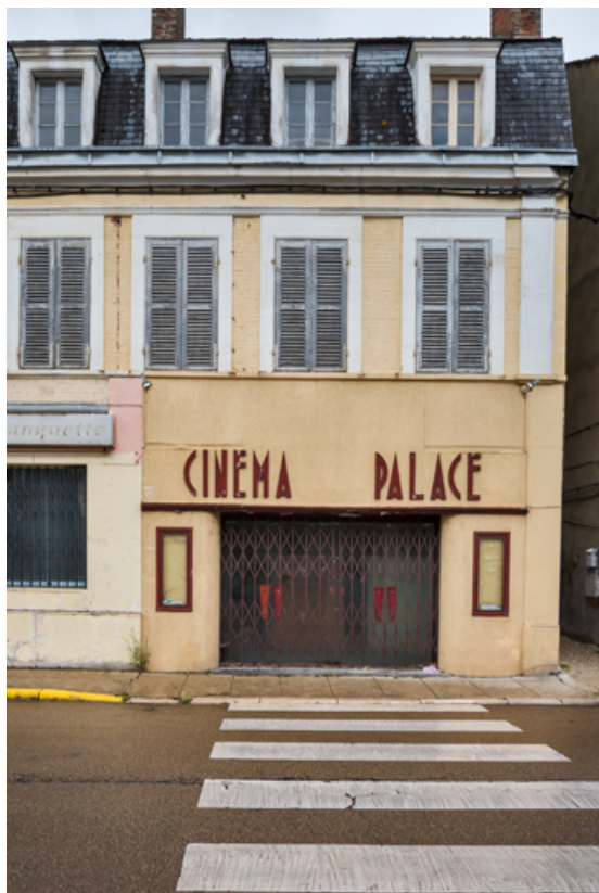
Saint-Florentin, 13 place Dilo : ancien cinéma Palace. Entrée.
