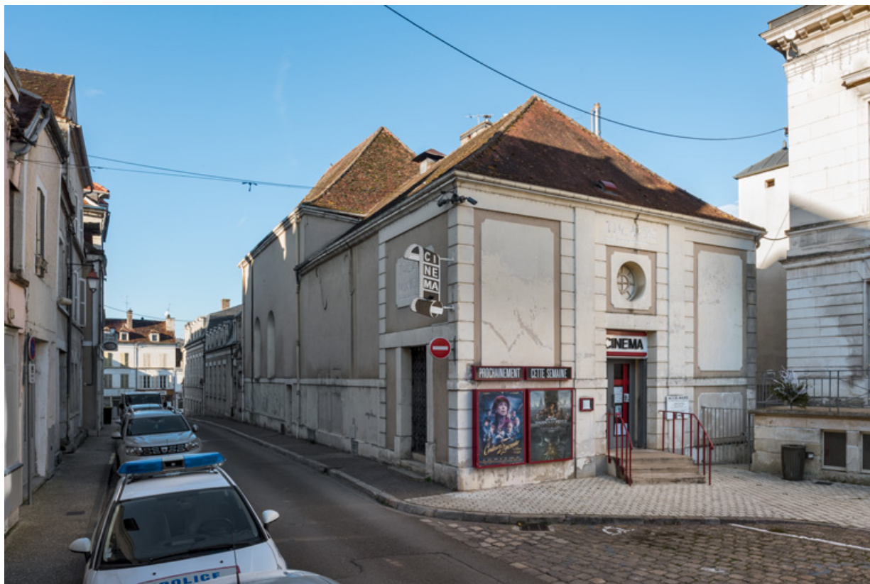
Façades antérieure et latérale gauche.
