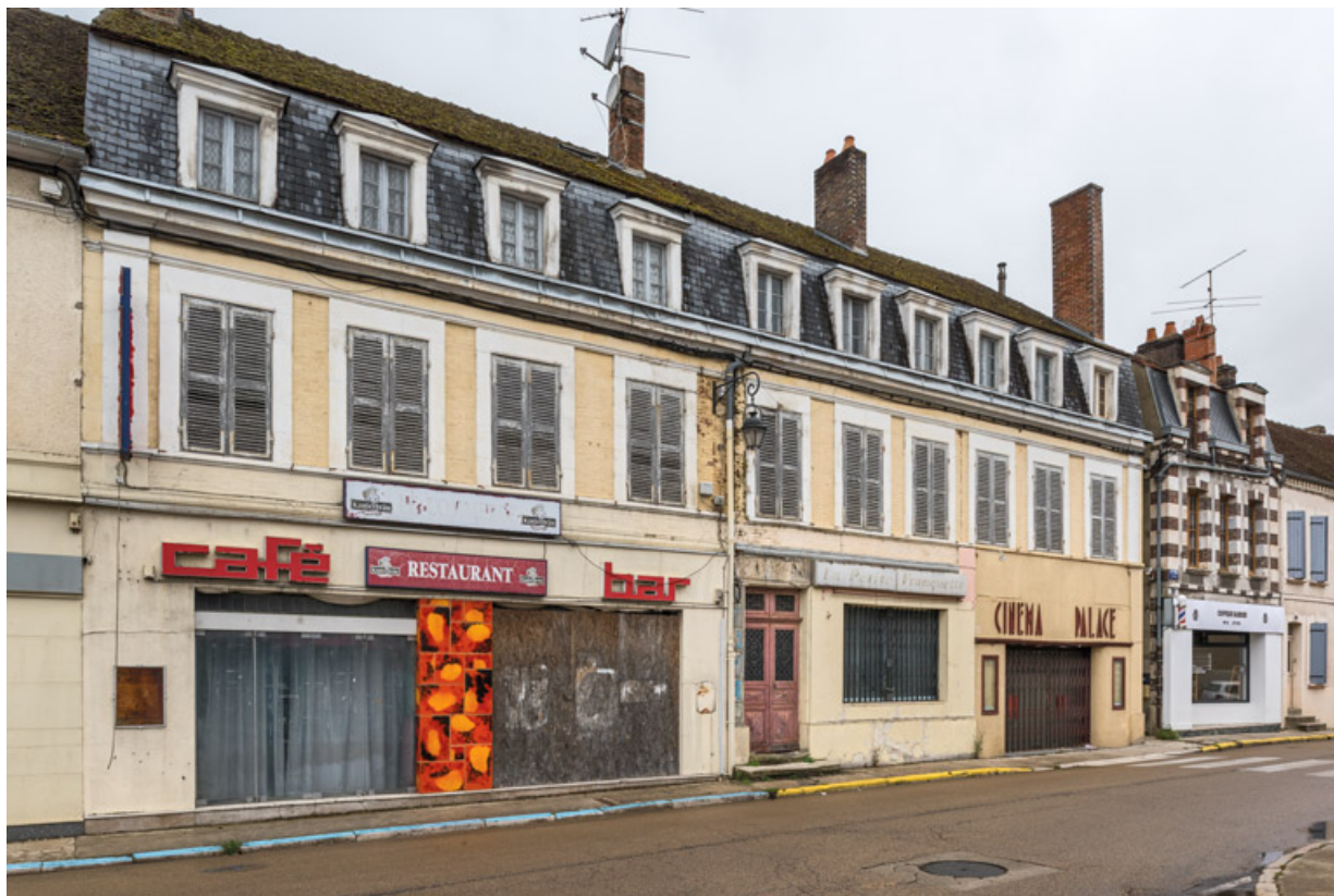
Saint-Florentin, 13 place Dilo : ancien cinéma Palace.
