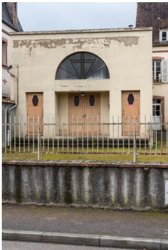
Saint-Julien-du-Sault, 13 Faubourg de la Croix : ancien cinéma Arc-en-Ciel.
