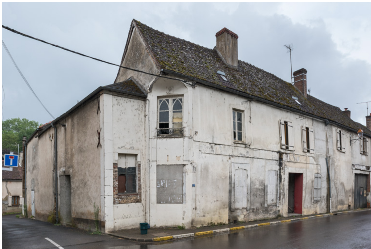
Toucy, 25 rue d'Arrault : ancien hôtel de Montargis puis cinéma Lux.
