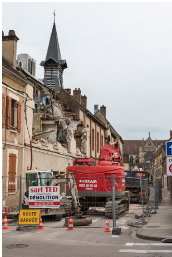
Cinéma Vox (14 rue Victor Guichard) en cours de démolition (22 mars 2023). 89, Sens
