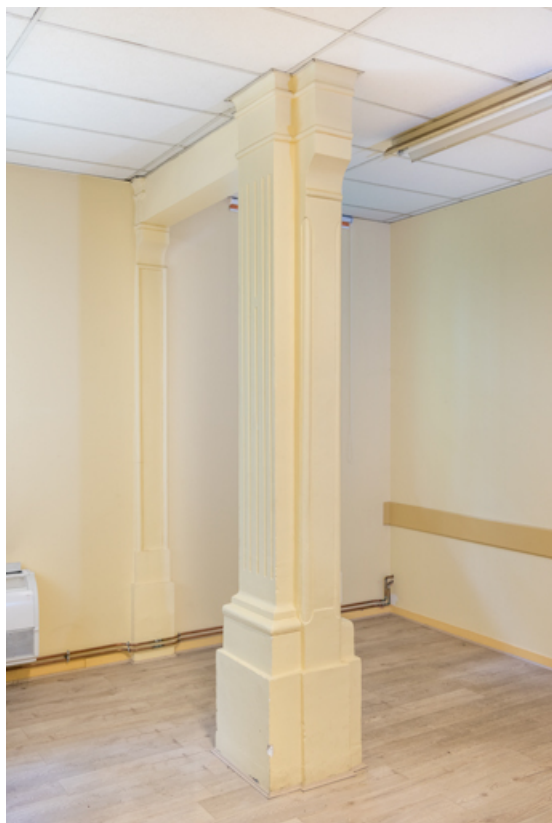
Pilier délimitant l'espace du chœur. Détail.
