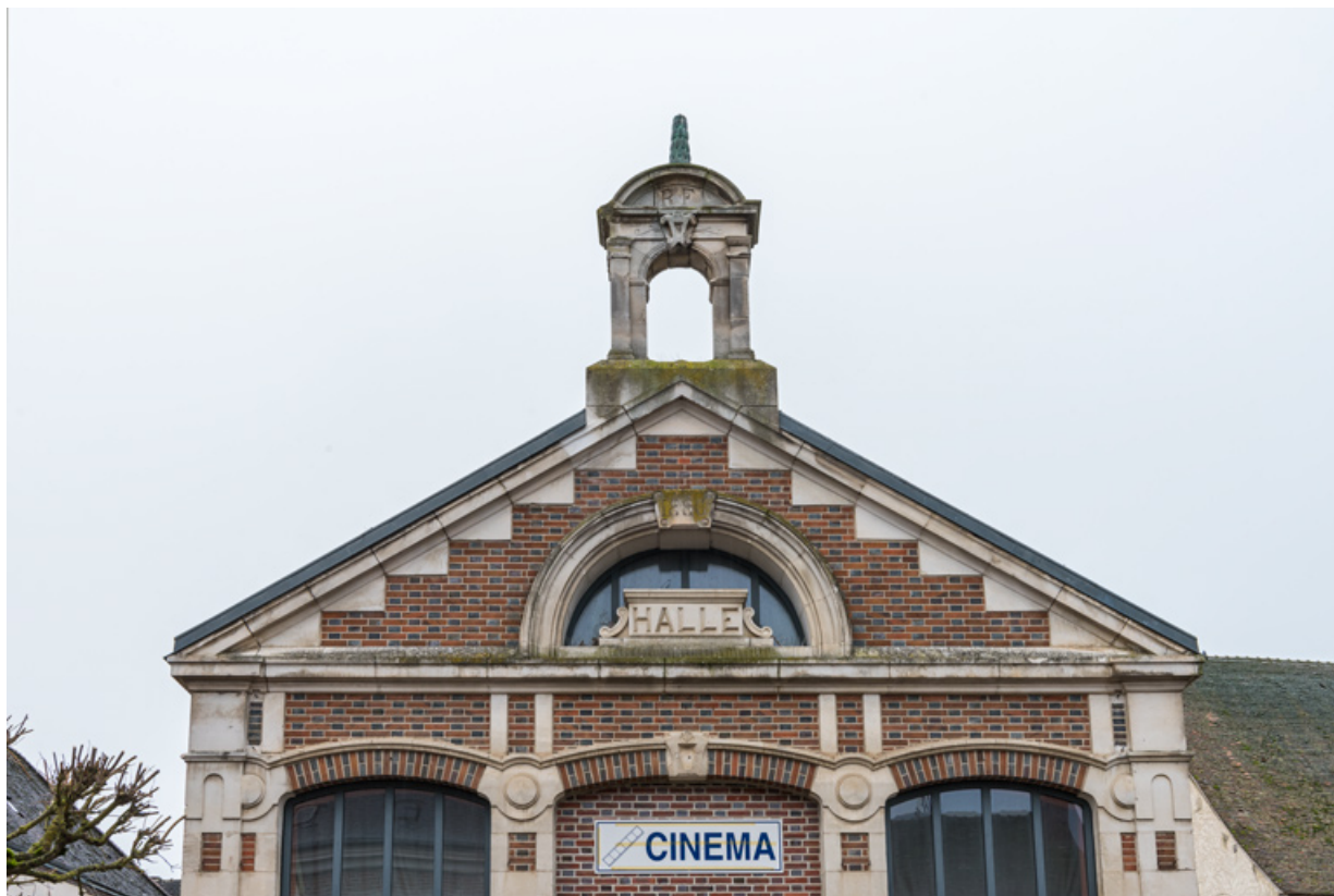
Façade antérieure : décor du pignon.
