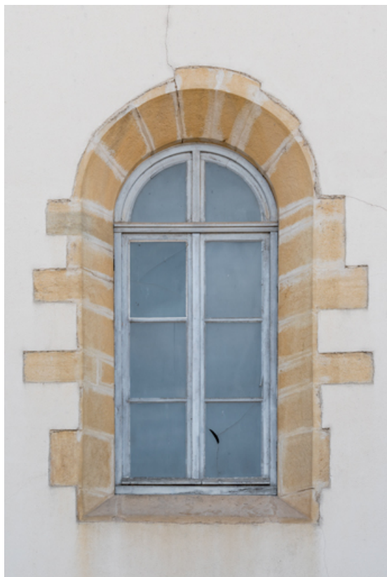
Façade latérale droite : une fenêtre.
