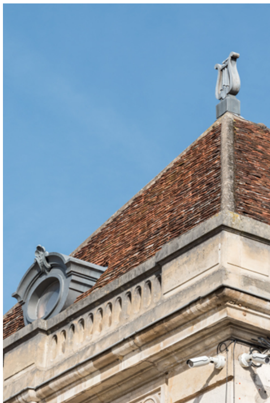
Façade antérieure : croupe et et épi de faitage en forme de lyre.
