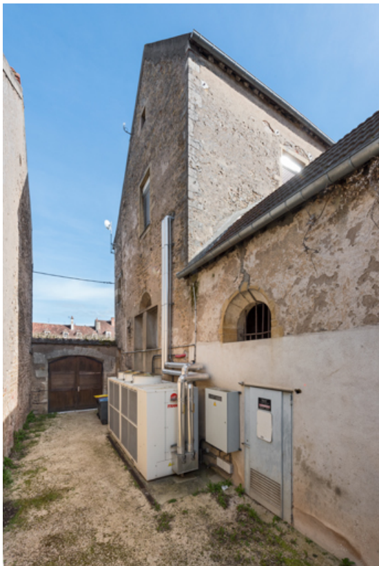
Façade postérieure, vue en enfilade.
