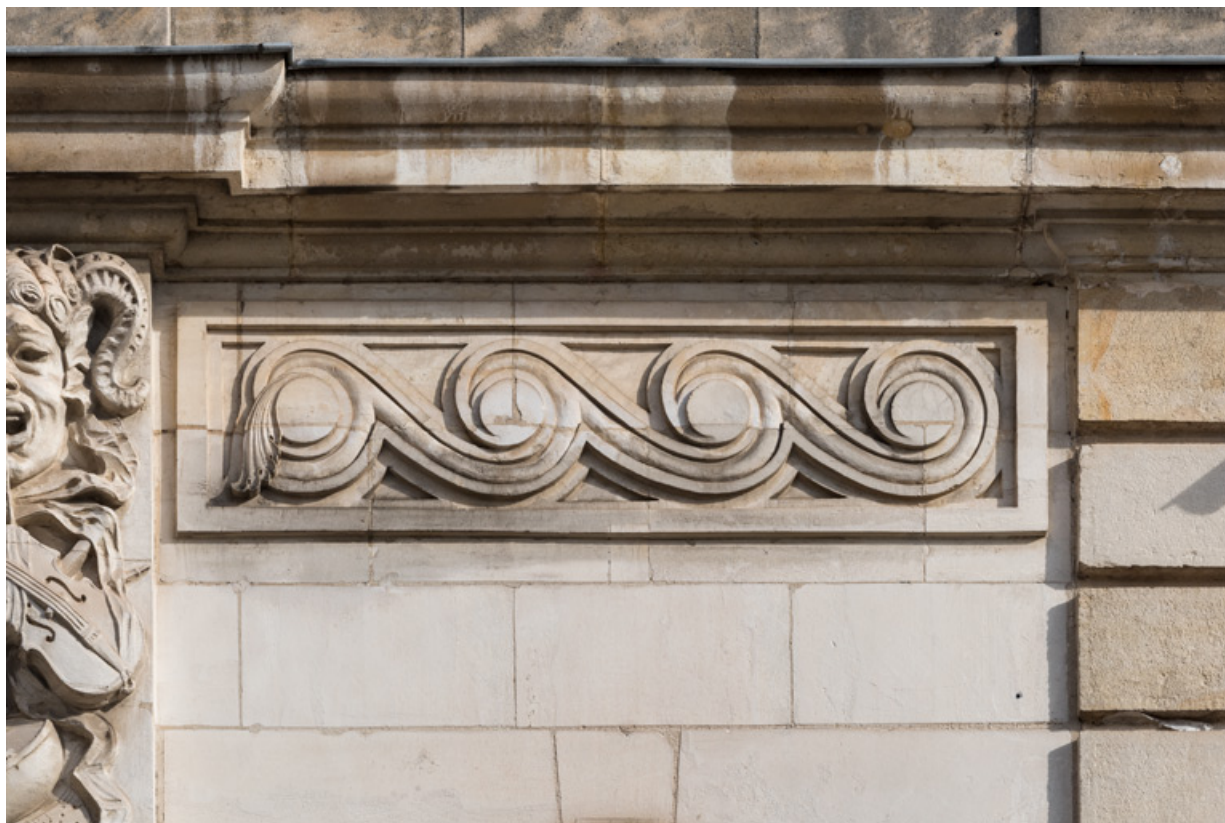
Façade antérieure : partie supérieure avec décor de postes.
