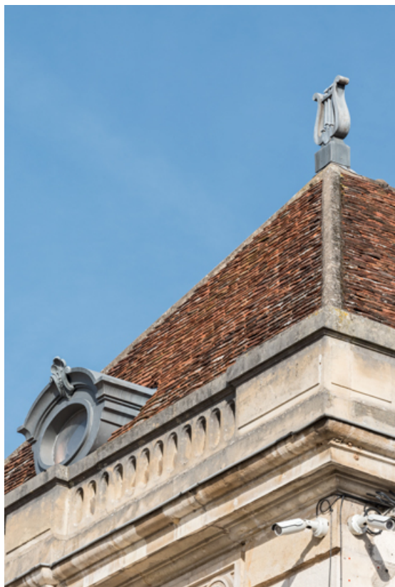
Façade antérieure : croupe et et épi de faitage en forme de lyre.
