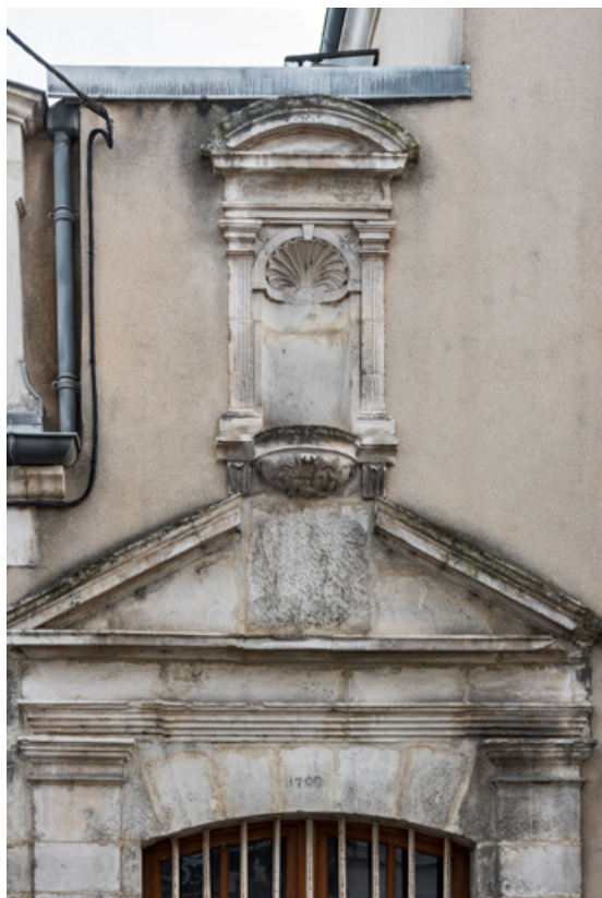
Façade latérale gauche : fronton et niche surmontant l'entrée murée. 89, Tonnerre, 261 rue de l' Hôtel de Ville
