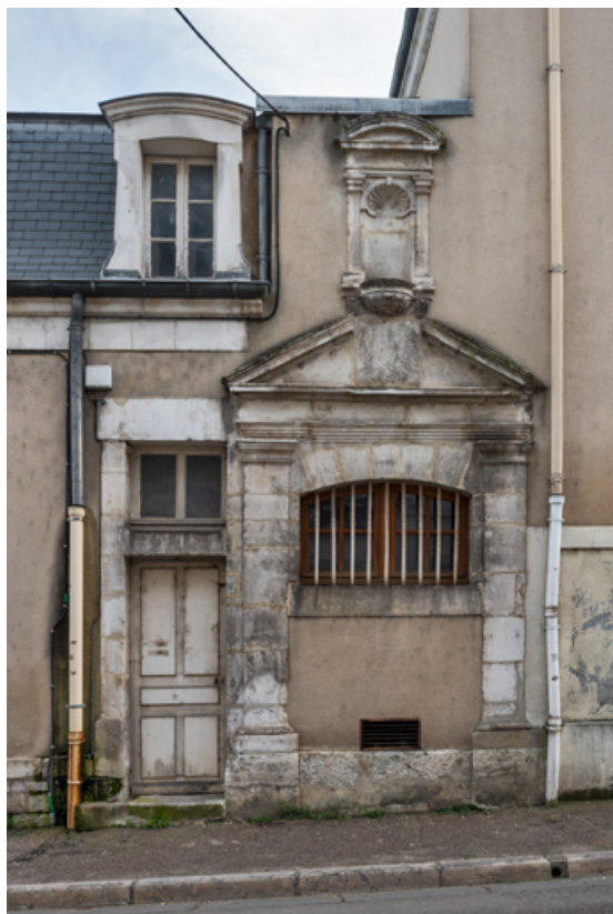
Façade latérale gauche : entrée des loges d'acteur et ancienne entrée murée. 89, Tonnerre, 261 rue de l' Hôtel de Ville
