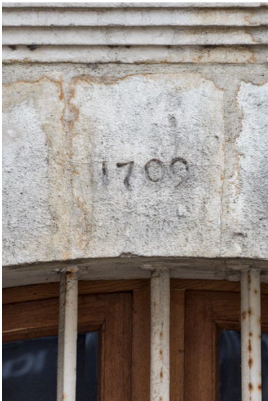
Façade latérale gauche : date 1709 sur l'arc de l'entrée murée.
