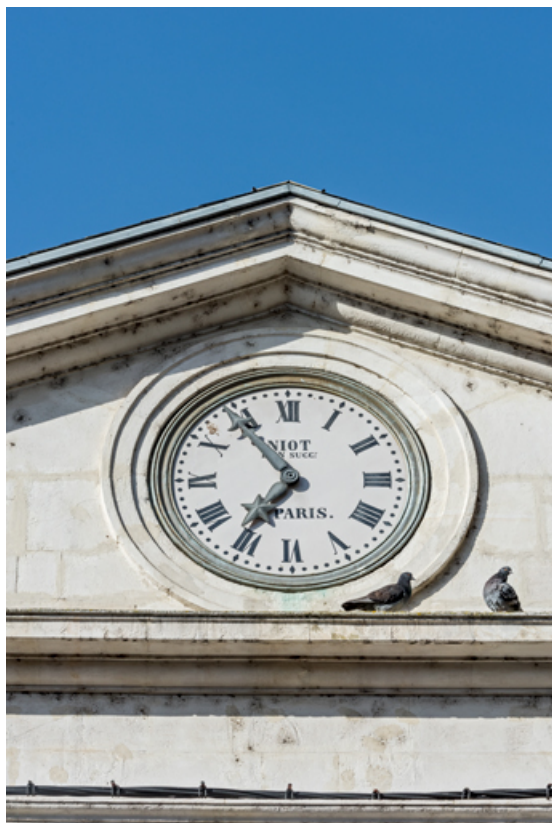
Façade antérieure, avant-corps central : horloge Niot. 89, Villeneuve-sur-Yonne, 25 rue Carnot
