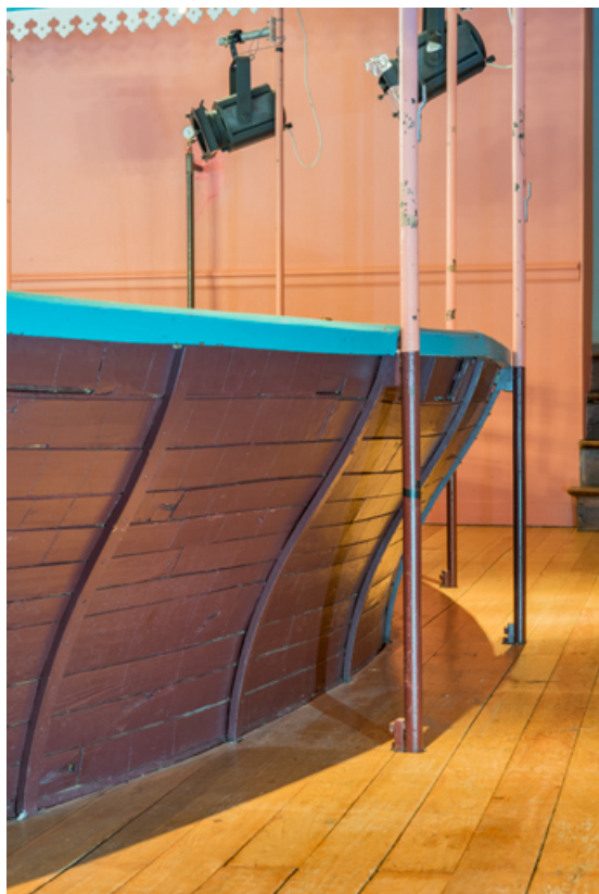
Balcon : garde-corps en bois et barres métalliques de suspension.
