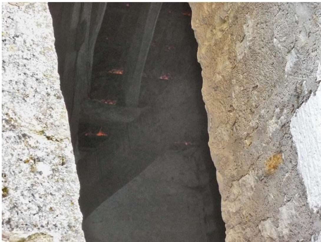
Chapelle, corps antérieur : détail de la charpente.
