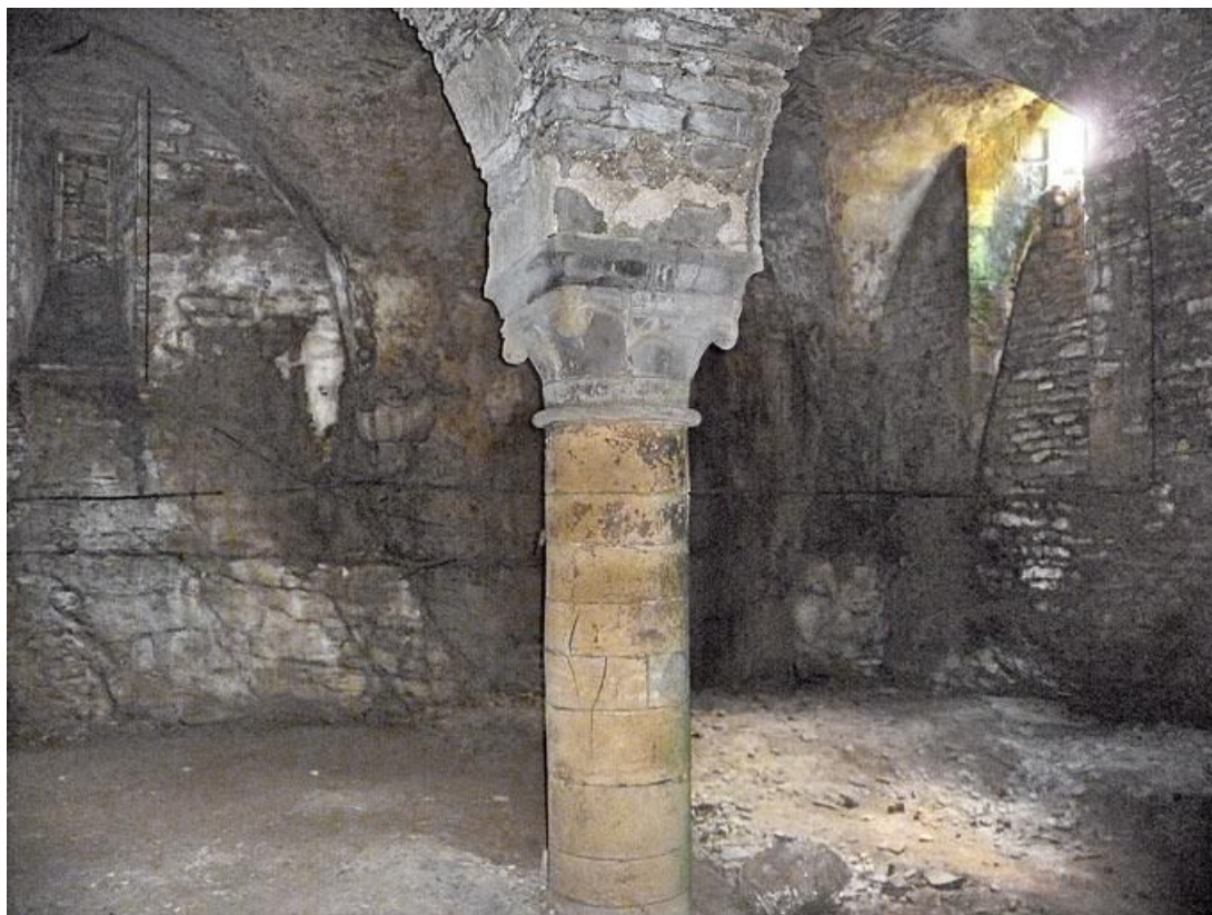
Cave sous la grange, vue d'un angle.
