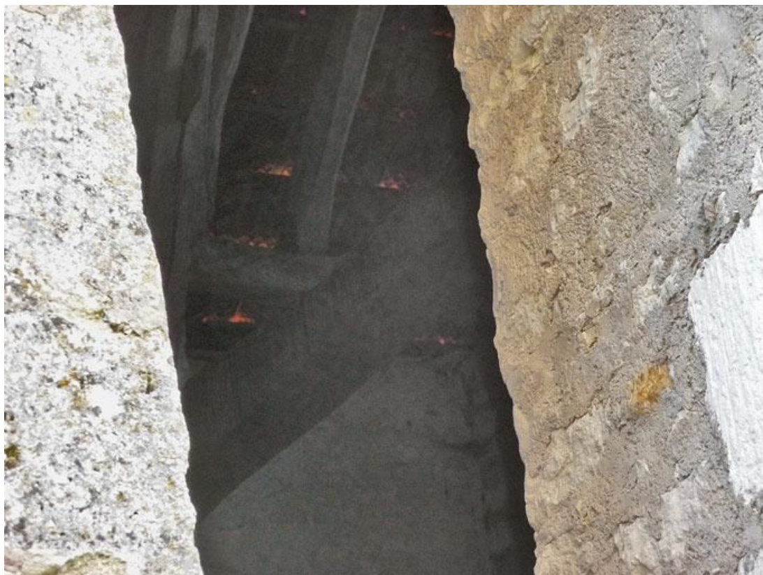
Chapelle, corps antérieur : détail de la charpente.
