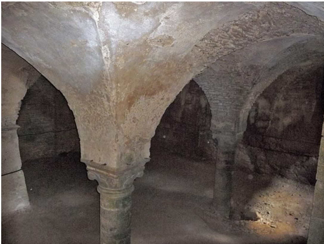
Cave sous la grange, vue d'ensemble depuis l'escalier.
