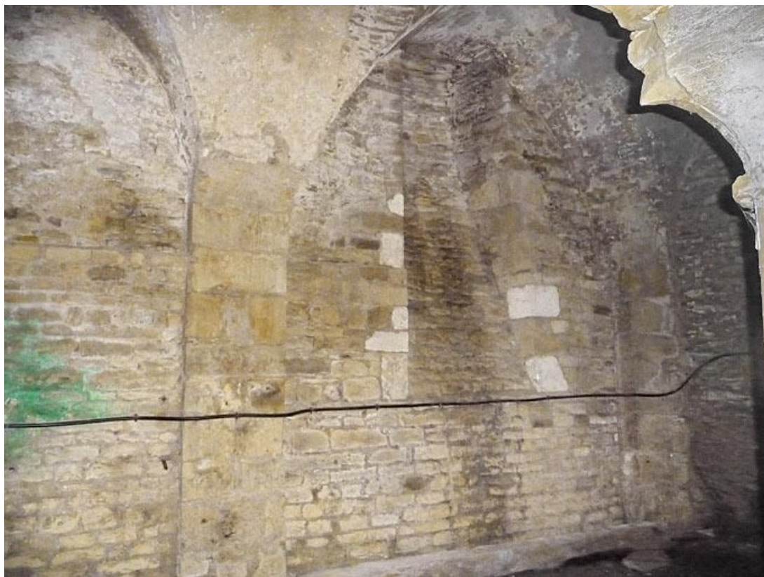
Cave sous la grange, pilastre et chapiteau d'une colonne.
