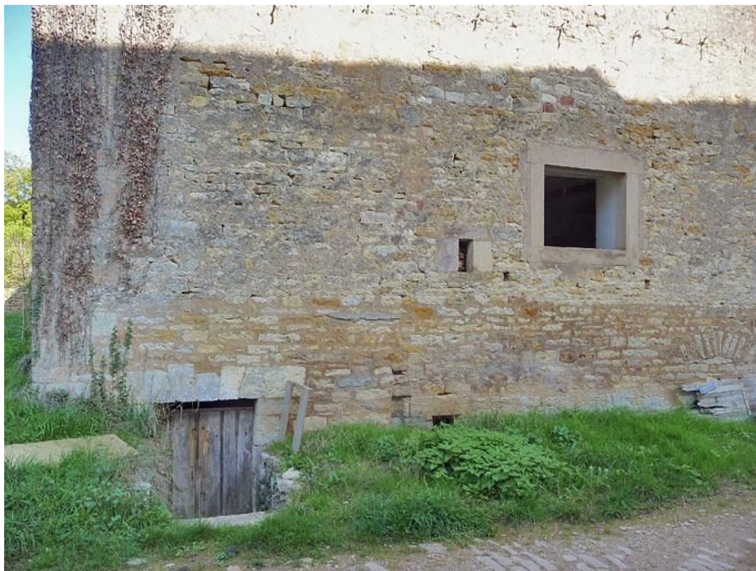
Entrée de la cave de la grange située dans le mur droit.
