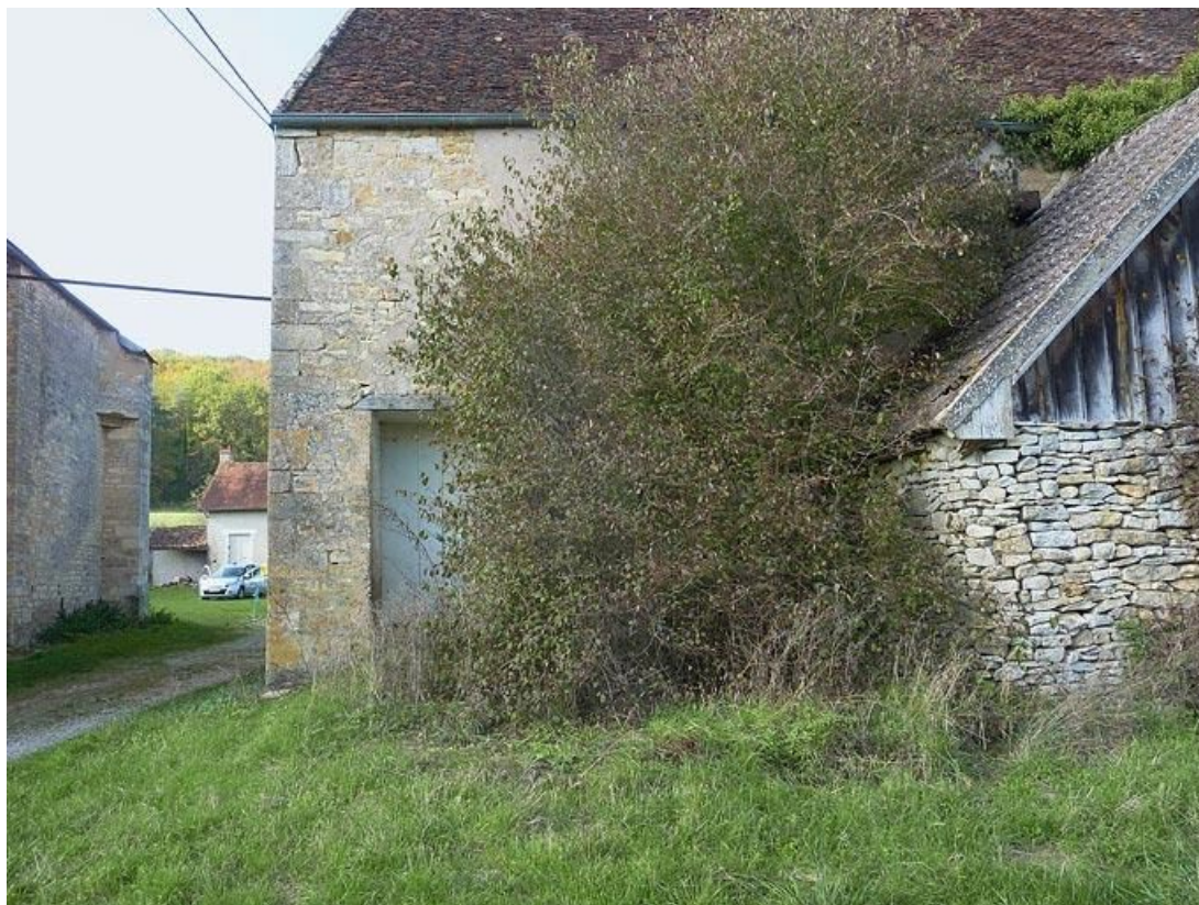
Partie du mur postérieur de la grange, côté entrée de la cour.
