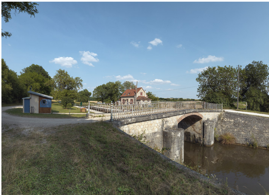
Le pont avec en arrière-plan le site d'écluse.
