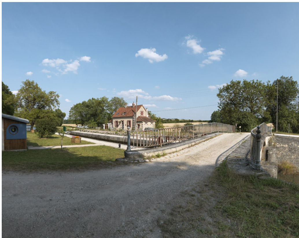
Vue sur le pont, avec à gauche le site d'écluse.
