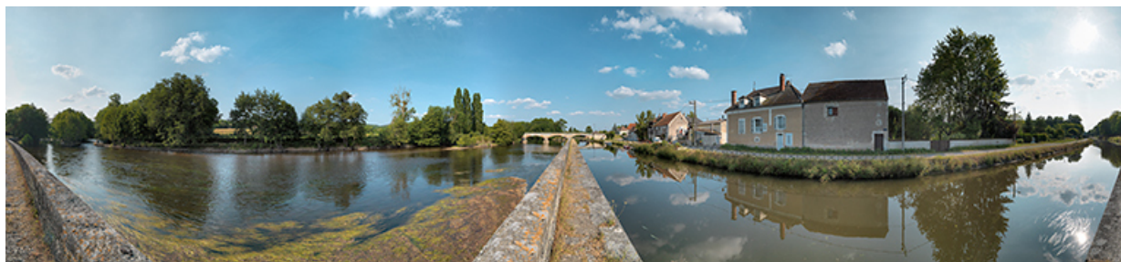
Panoramique : pont d'Accolay et village sur la droite, vus depuis la digue. A gauche, la Cure.
