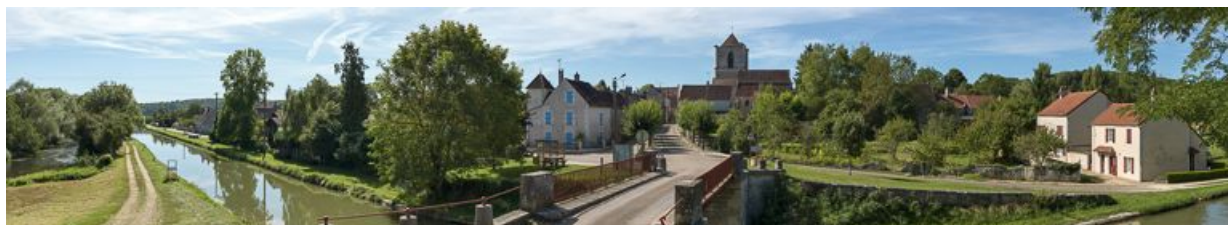
Vue d'ensemble du village de Lucy, avec l'église au centre. Au premier plan, le pont routier isolé.
