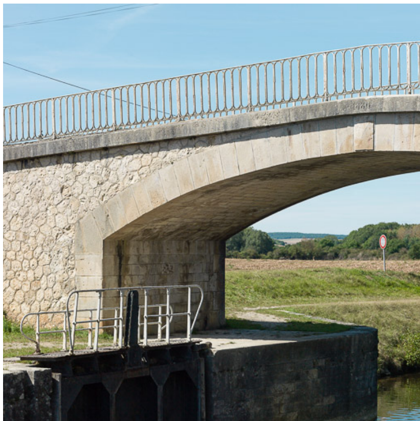
Détail des culées en moellon d'appareil polygonal et de la voûte en anse de panier en pierre.
