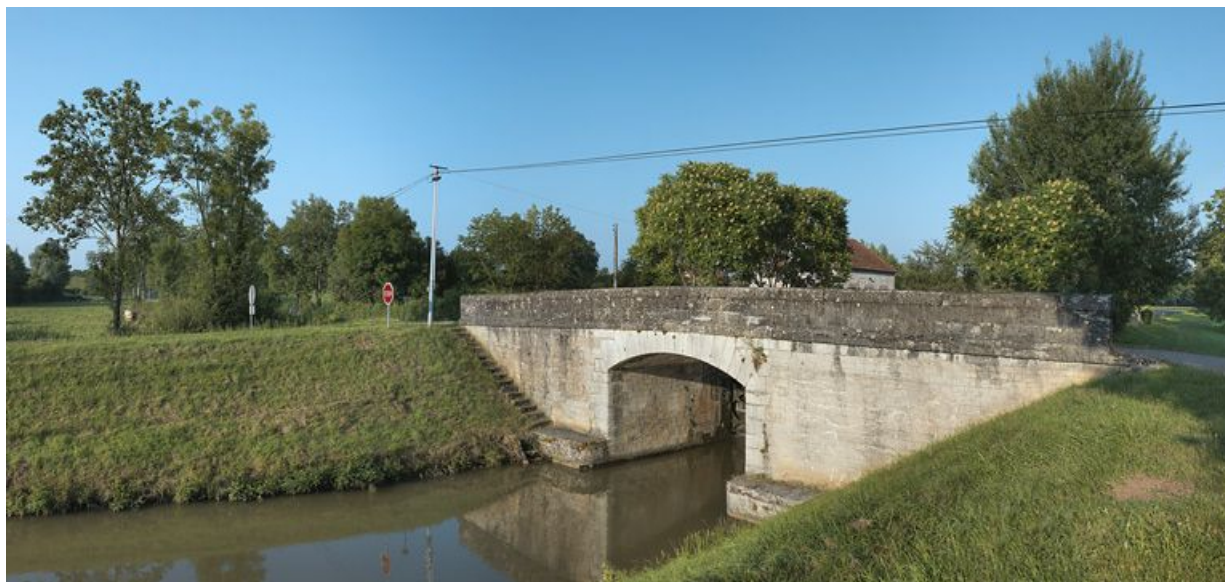
Vue d'aval du pont.
