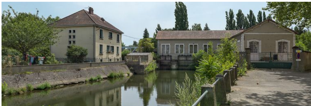
Le moulin et le bief de dérivation. A gauche, l'arrière de la maison éclusière.
