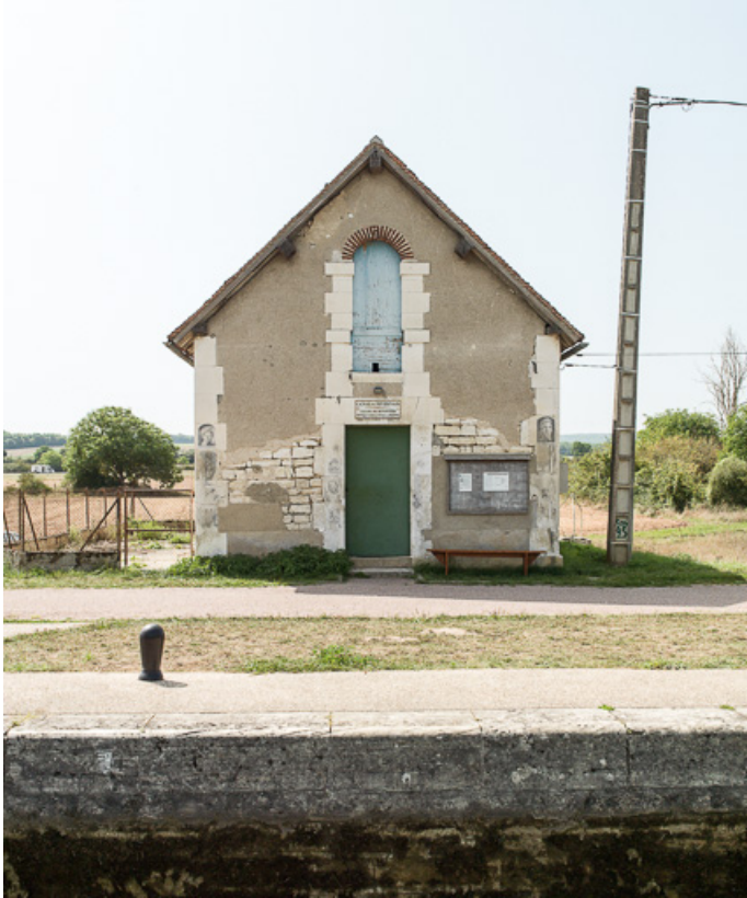
Vue du mur pignon de la maison éclusière.
