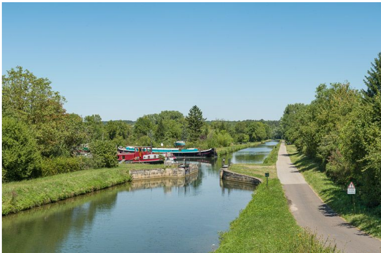
Vue d'ensemble de l'écluse avec le port en aval (IA89001939).
