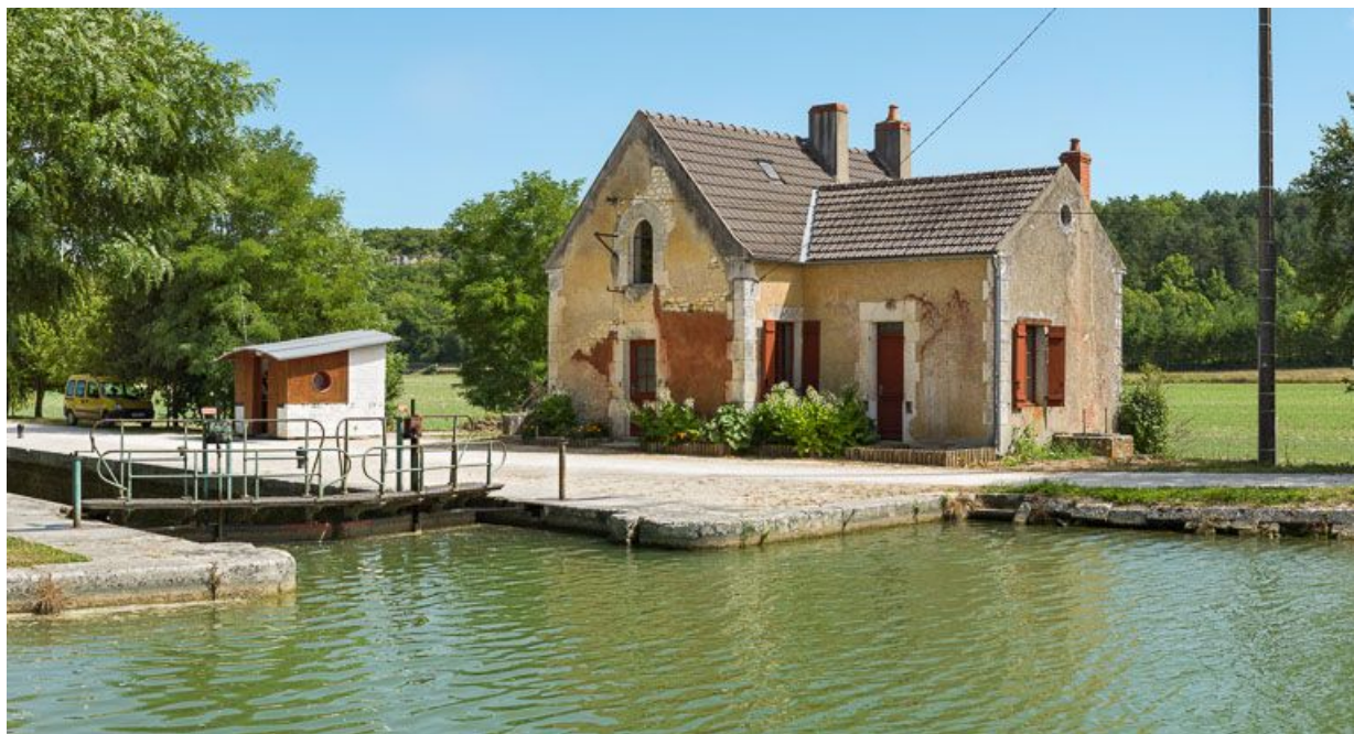
Vue générale du site d'écluse, avec la maison de 3/4.
