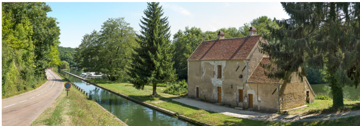
Vue générale de la maison de garde.
