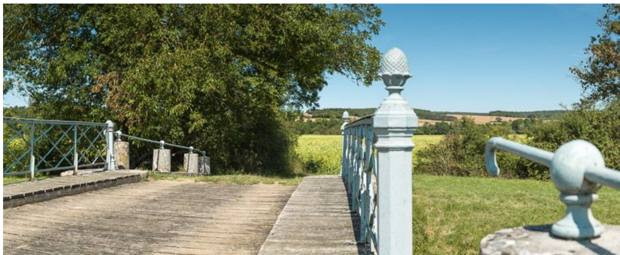
Détail du tablier en bois et des garde-corps en métal, avec pomme de pin.
