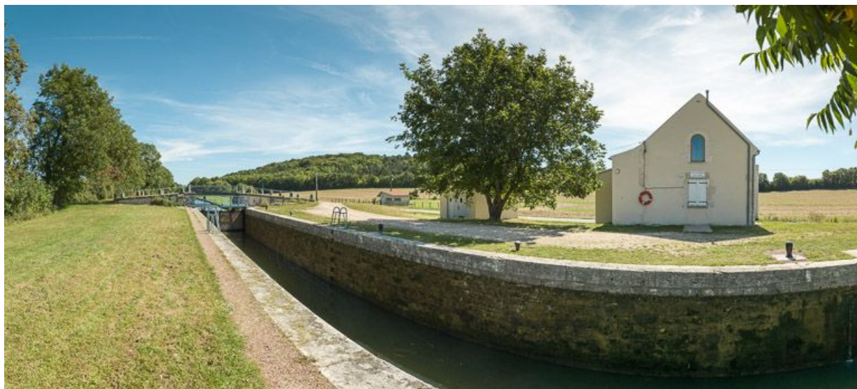
Vue d'ensemble du site avec maison éclusière de type Poirée de face.
