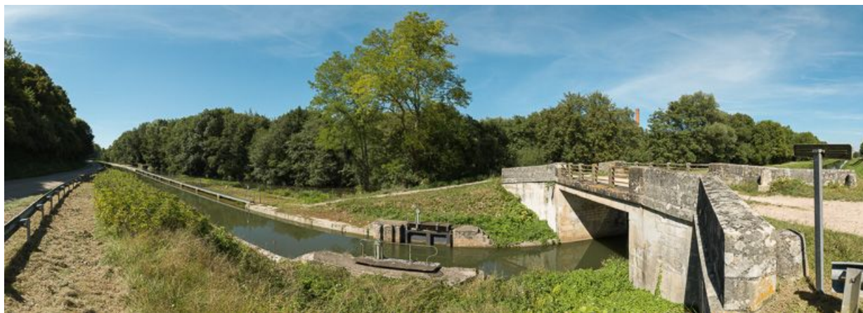
Vue d'ensemble de l'écluse de garde. On aperçoit la cheminée de l'ancienne usine (IA89002010). 89, Lucy-sur-Yonne, lieudit : bief 54 du versant Seine
