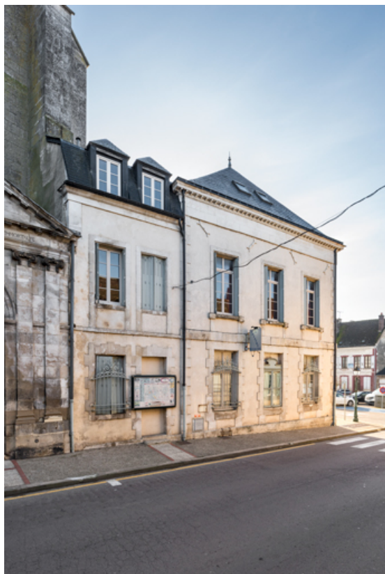
Façade latérale gauche, de trois quarts droite. 89, Brienon-sur-Armançon, 2 place Emile Blondeau
