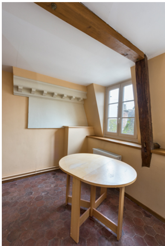
Etage en surcroît de l'extension (au nord) : loge d'acteur. Le retour de la corniche à modillons extérieure est toujours visible. 89, Briennon-sur-Armançon, 2 place Emile Blondeau
