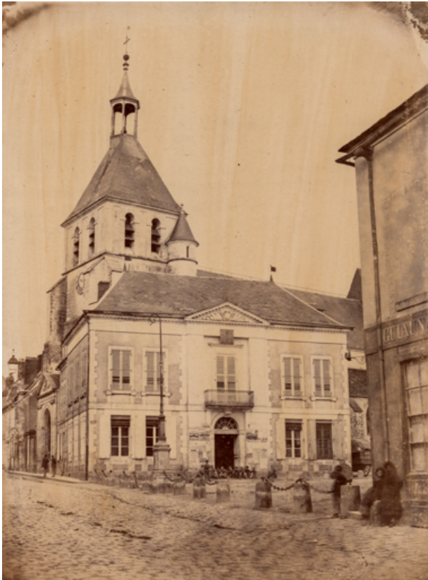
[Façade antérieure de la mairie, de trois quarts gauche]. S.d. [vers 1868]. 89, Brienon-sur-Armançon, 2 place Emile Blondeau
