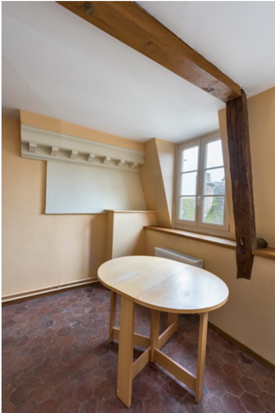
Etage en surcroît de l'extension (au nord) : loge d'acteur. Le retour de la corniche à modillons extérieure est toujours visible. 89, Brienon-sur-Armançon, 2 place Emile Blondeau
