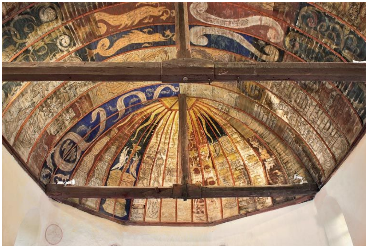
Vue de la voûte lambrissée et de son décor peint.
