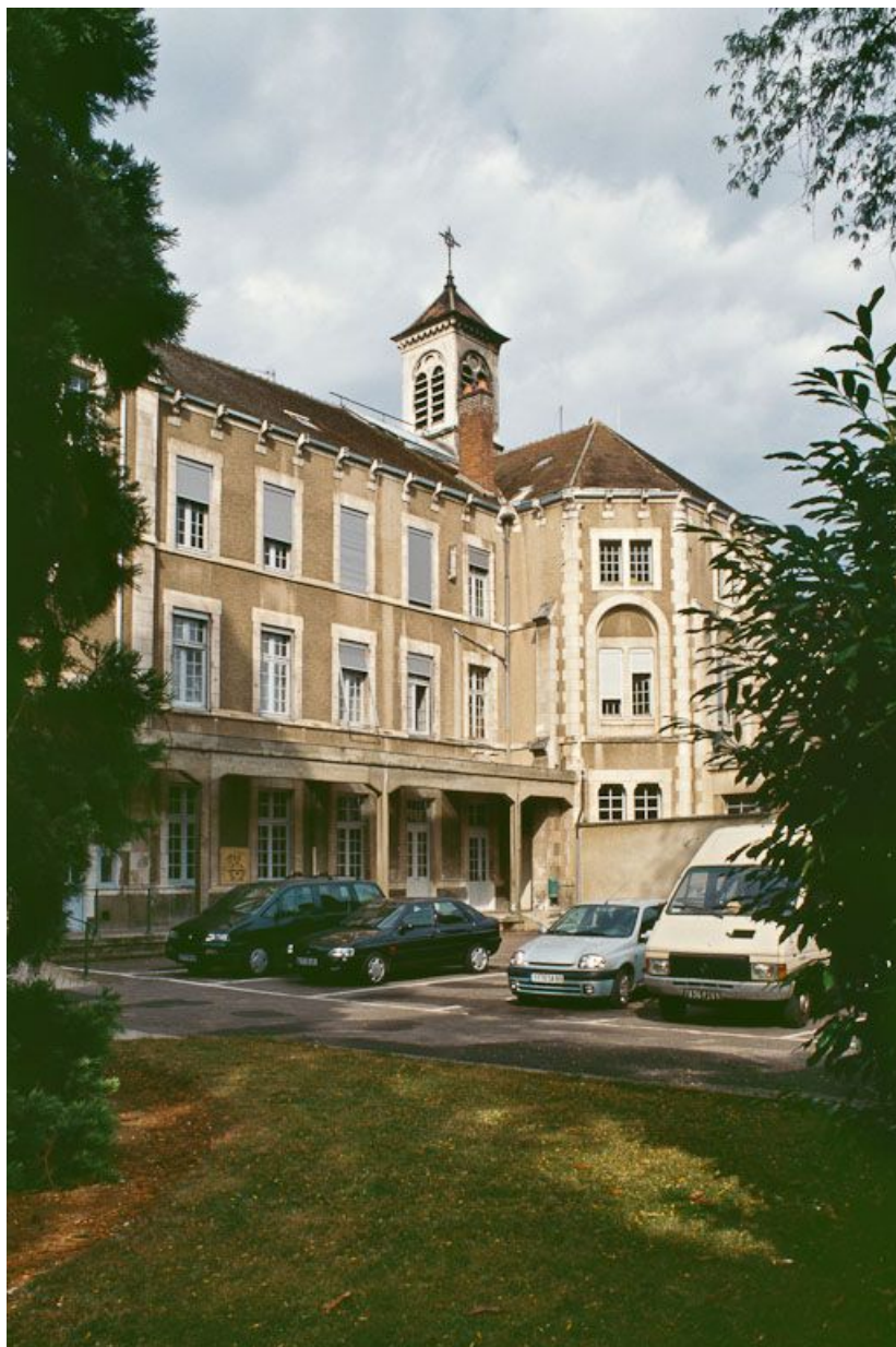
Bâtiment central, façade postérieure avec galerie en 2001.
