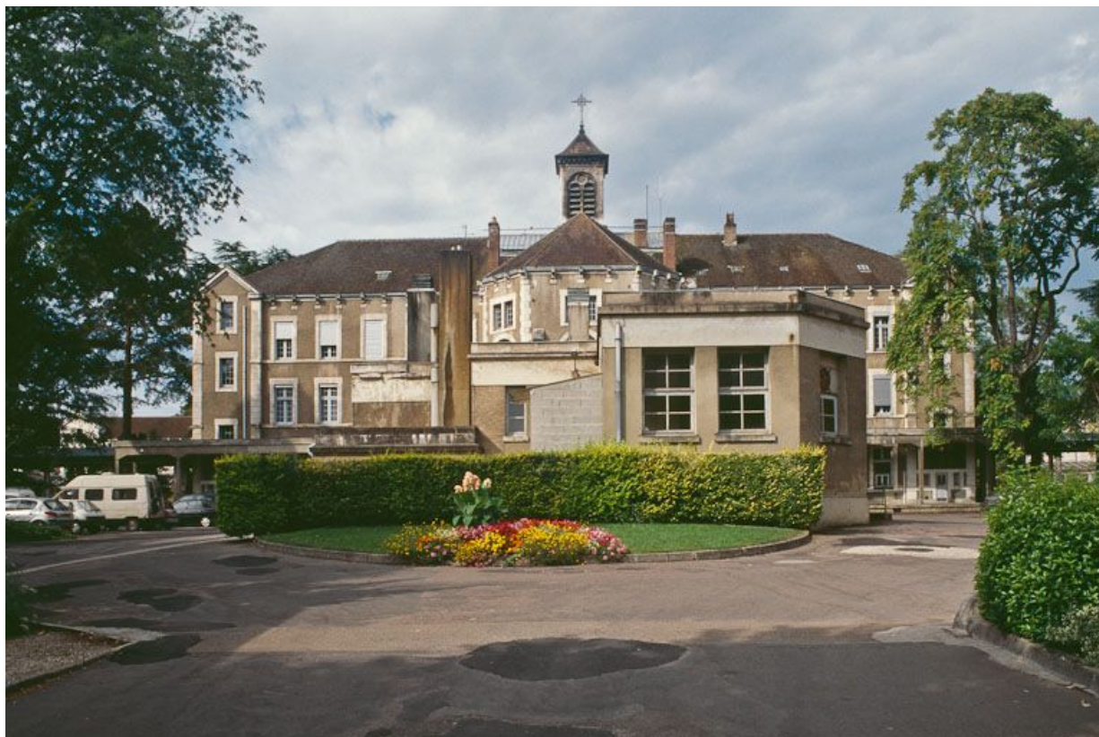
Bâtiment central, façade postérieure et cuisine construite en 1958.
