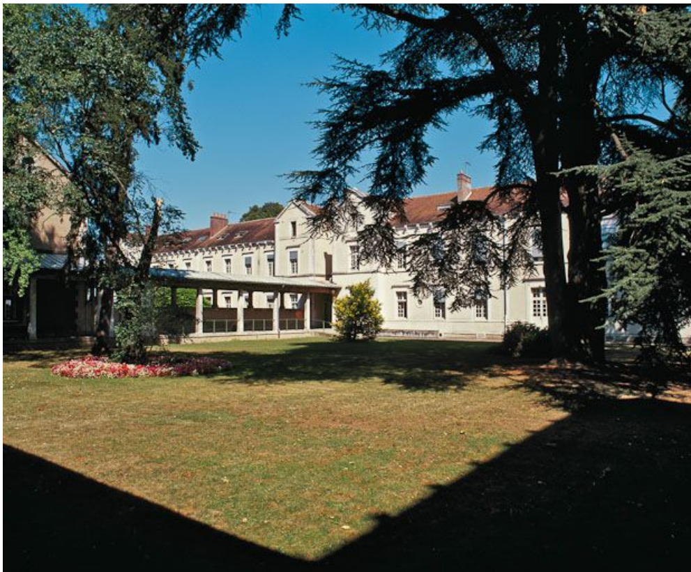
Bâtiment central, partie gauche de la façade en 2001.
