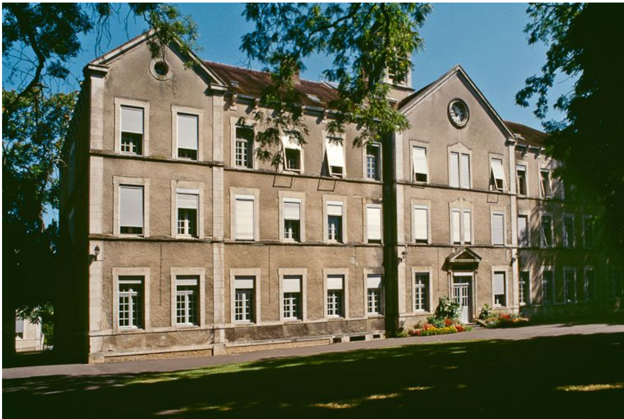
Bâtiment central, partie gauche de la façade.
