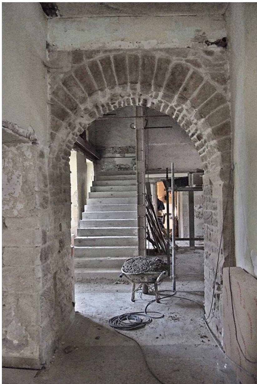
Couloir et escalier pendant les travaux.
