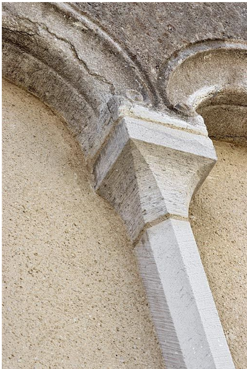
Aile du logis, élévation sur la rue de l'hôpital : détail.
