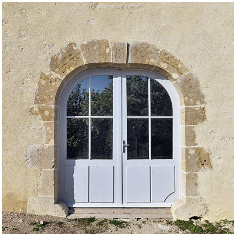
Porte du bâtiment situé de l'autre côté de la rue du Château.
