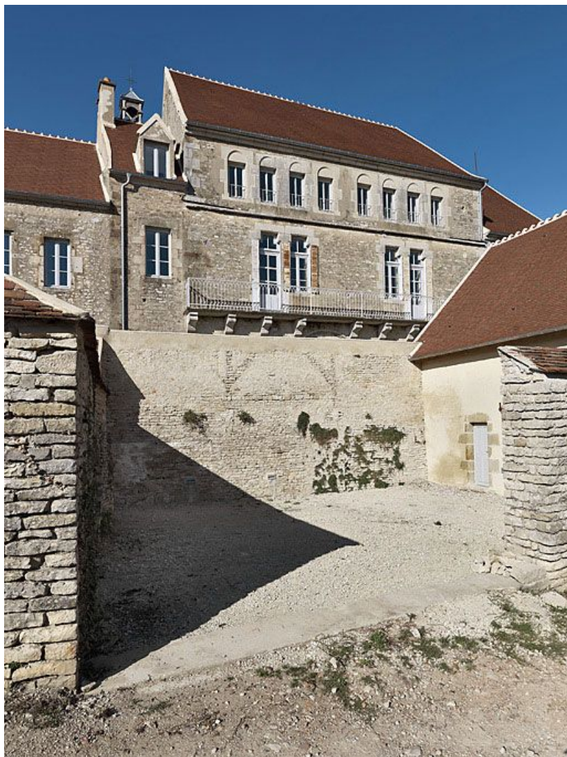
Façade postérieure du corps de bâtiment principal.
