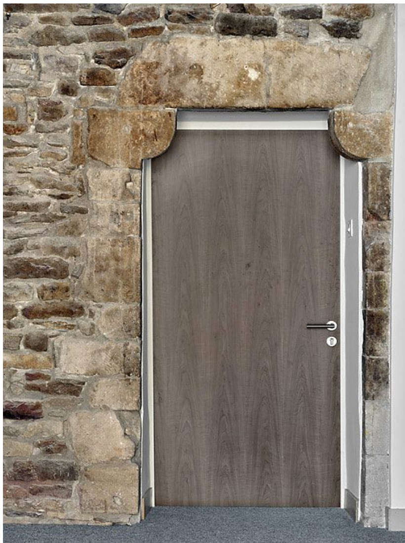
Porte à coussinets située près de la tour d'escalier.
