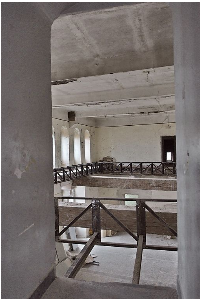
Pièces au-dessus de la salle voûtée pendant les travaux.
