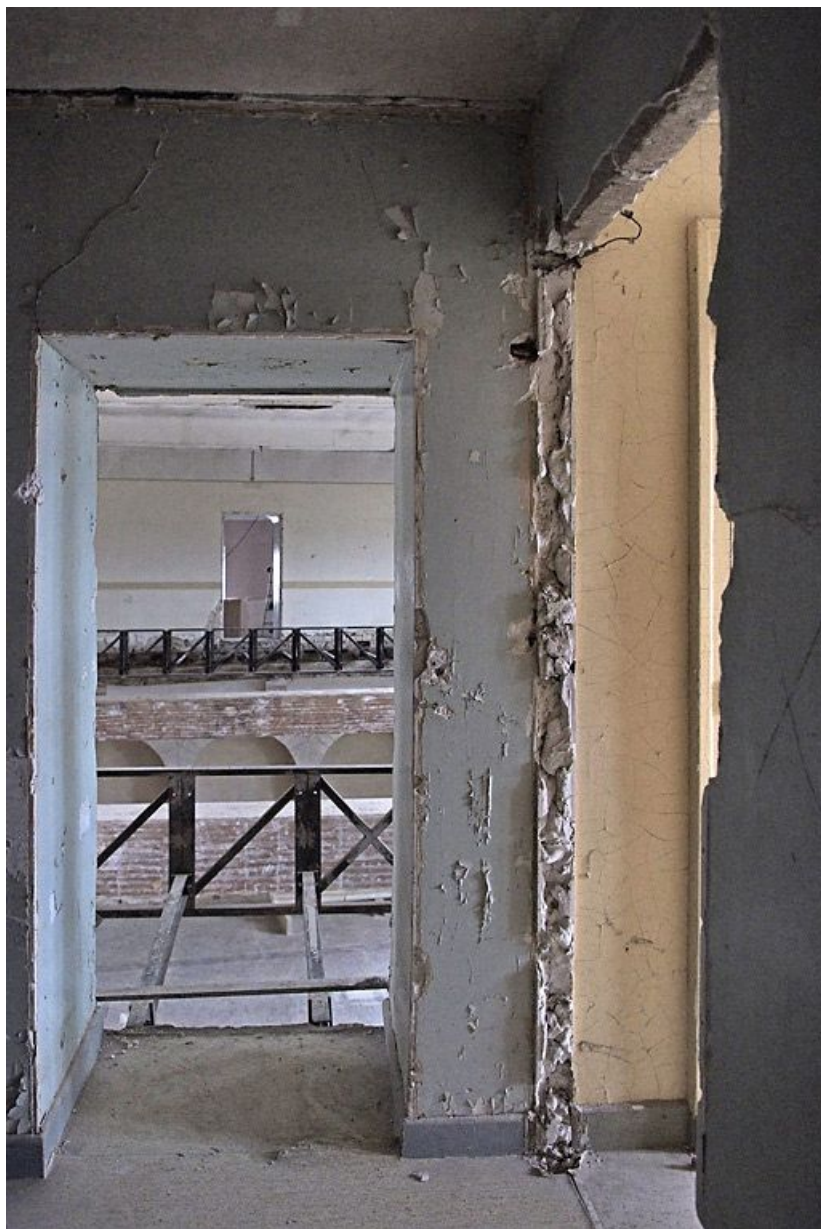
Pièce au-dessus de la salle voûtée pendant les travaux.
