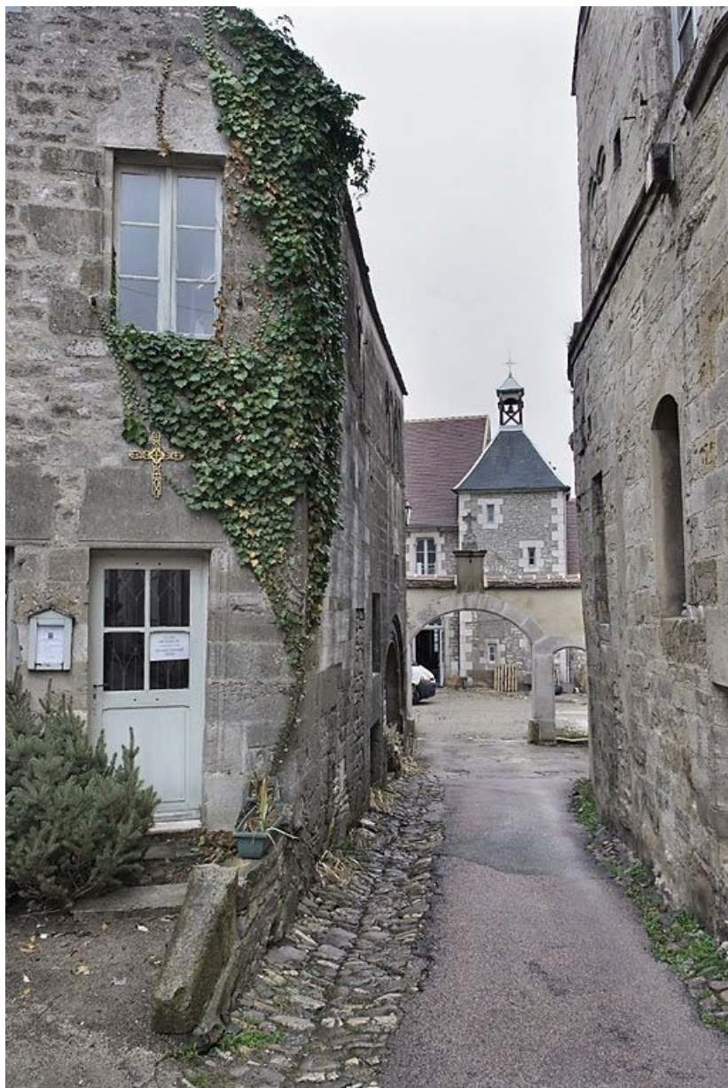
Vue d'ensemble depuis la rue du Couvent.
