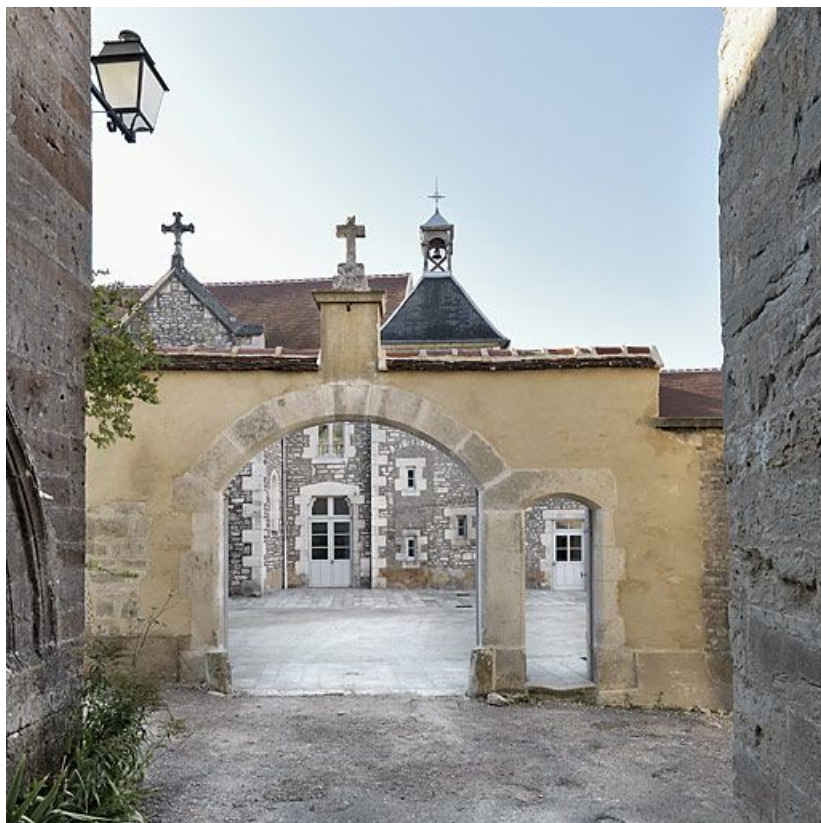
Vue d'ensemble depuis la rue du Couvent.
