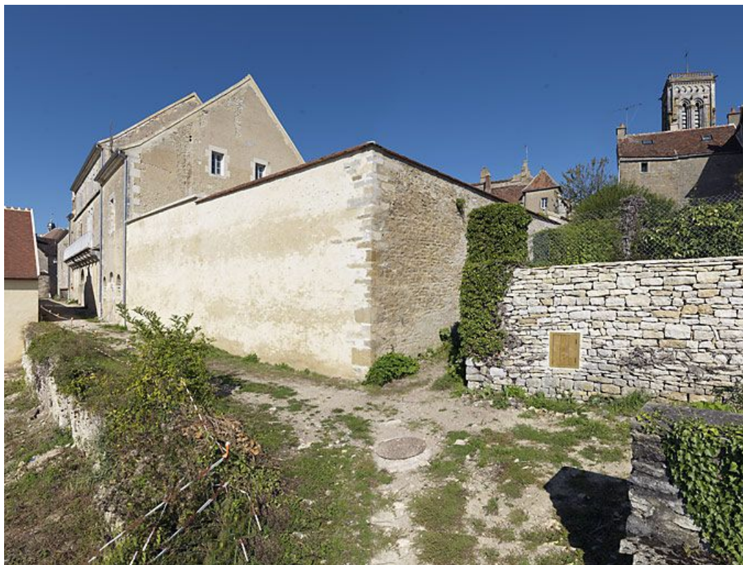
Vue d'ensemble prise du sud-est.
