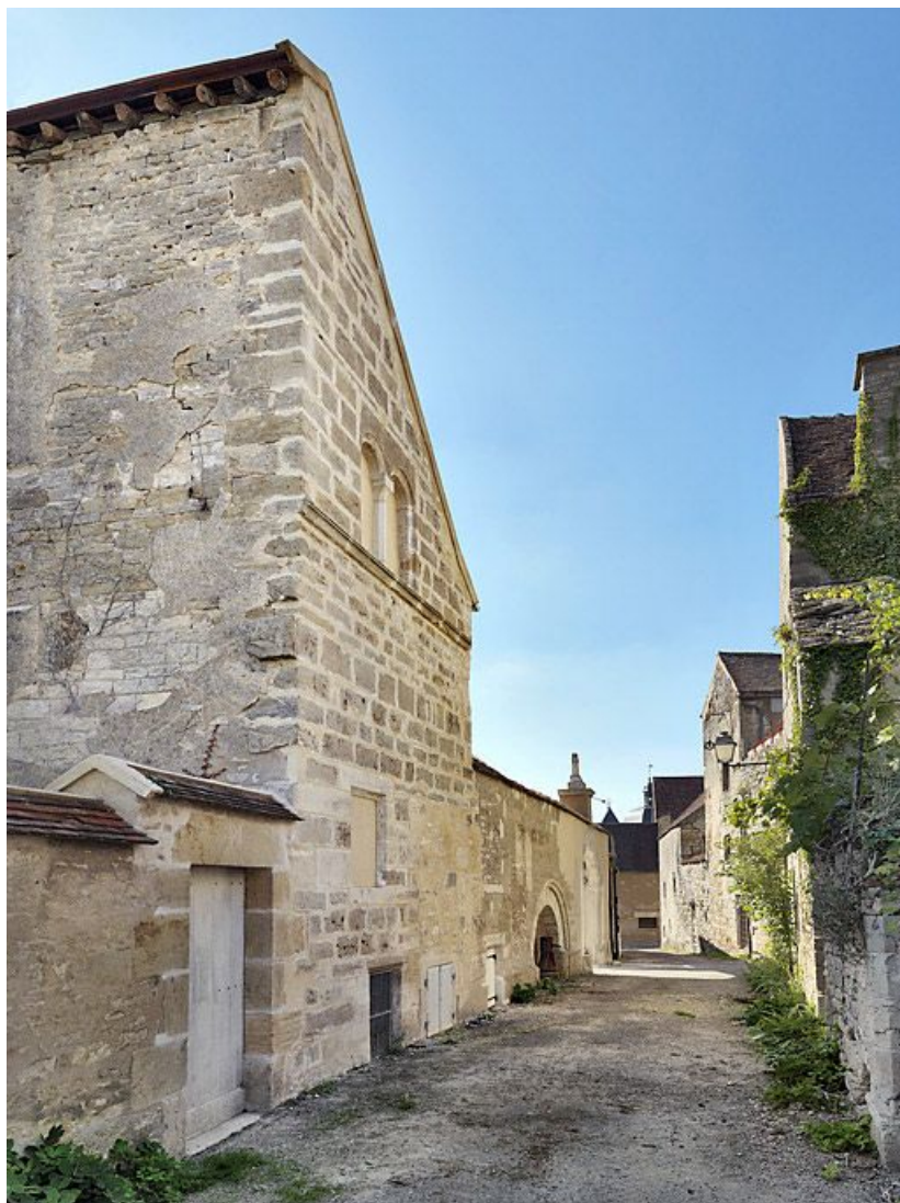
Aile du logis, élévation sur la rue de l'hôpital.
