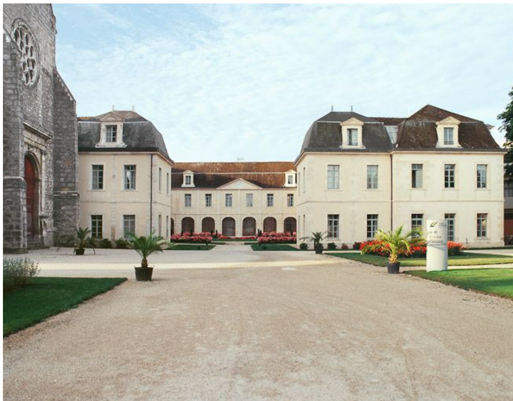
Vue d'ensemble depuis l'entrée de la cour intérieure.
