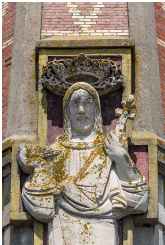
Bas-relief du clocher. Détail de la partie supérieure.
