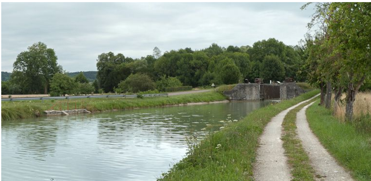
Vue de l'arrivée de la rigole d'alimentation en aval du site d'écluse 93 du versant Yonne.
