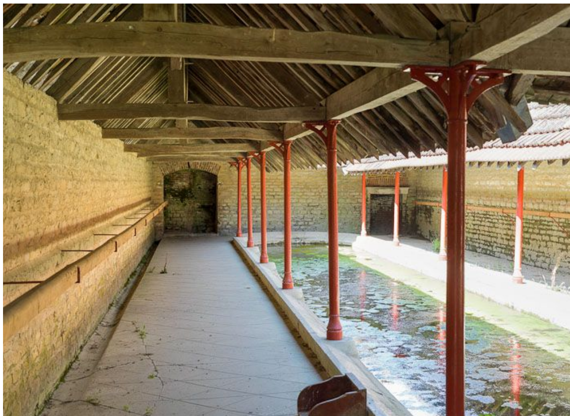
Vue de l'intérieur et des colonnes en fonte soutenant la toiture en impluvium.
