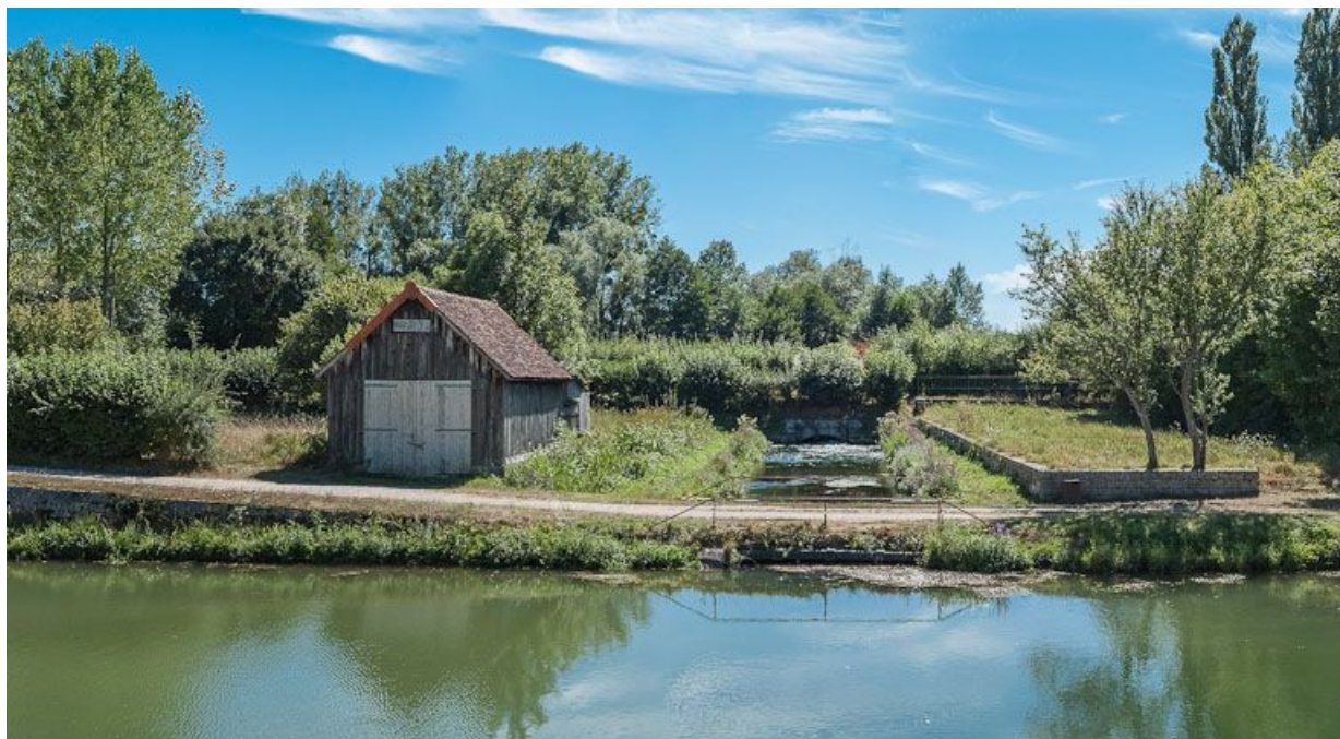
Le bassin lié à la prise d'eau d'Ancy-le-Franc. Remise à gauche du bassin.
