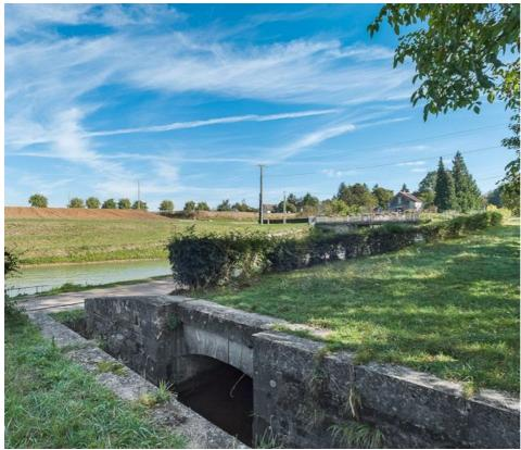
**Détail de la maçonnerie de l'ancienne prise d'eau dans la rigole. Ecluse en arrière-plan.** 89, Germigny, lieudit : bief 106-107 du versant Yonne
