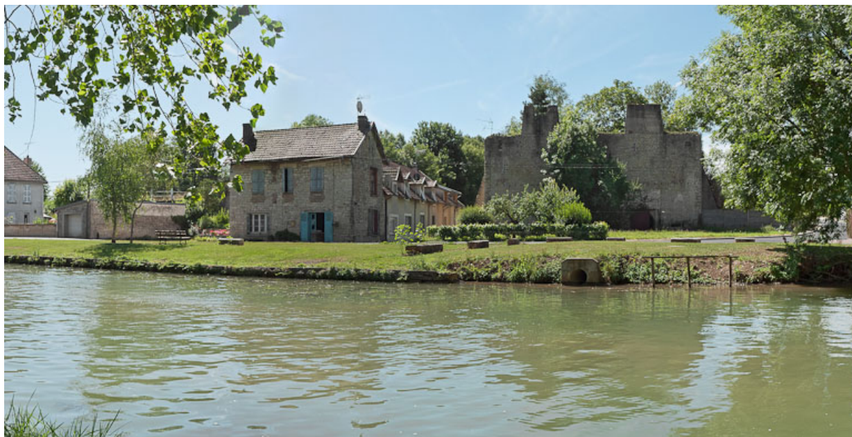
Vue générale du site depuis le canal.
