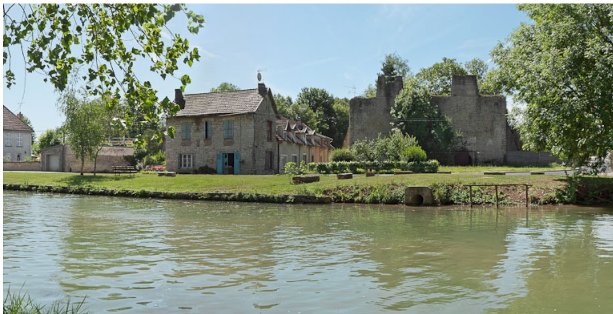
Vue générale du site depuis le canal.
