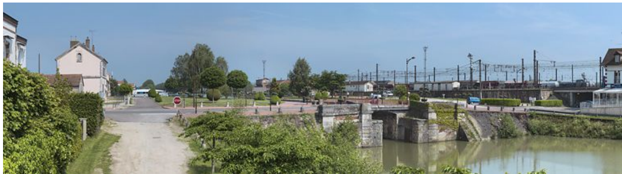
Grand panorama sur l'avant-port. De gauche à droite : le site d'écluse, port, le site SNCF.
