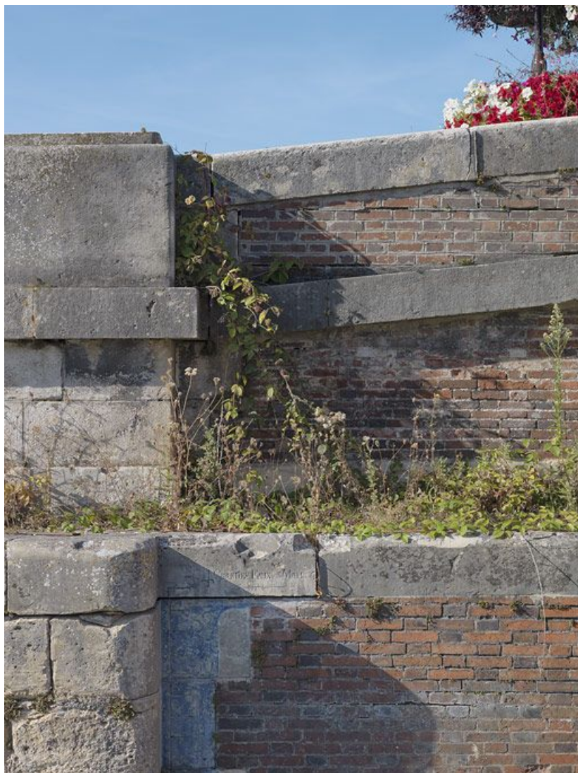
Le pont routier sur l'écluse 114-115 du versant Yonne : détail des maçonneries avec l'échelle de crues. 89, Migennes, lieudit : bief 114-115 du versant Yonne
