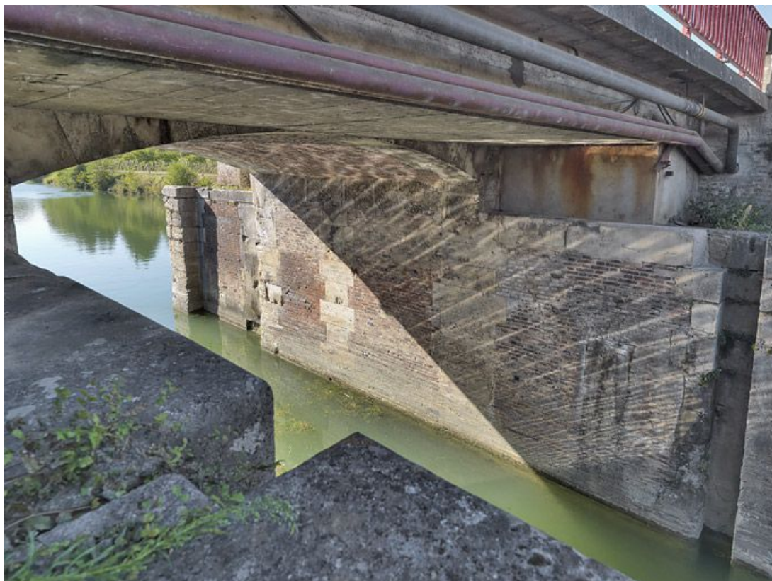
Le pont routier sur l'écluse 114-115 du versant Yonne : détail des maçonneries du dessous du tablier. 89, Migennes, lieudit : bief 114-115 du versant Yonne
