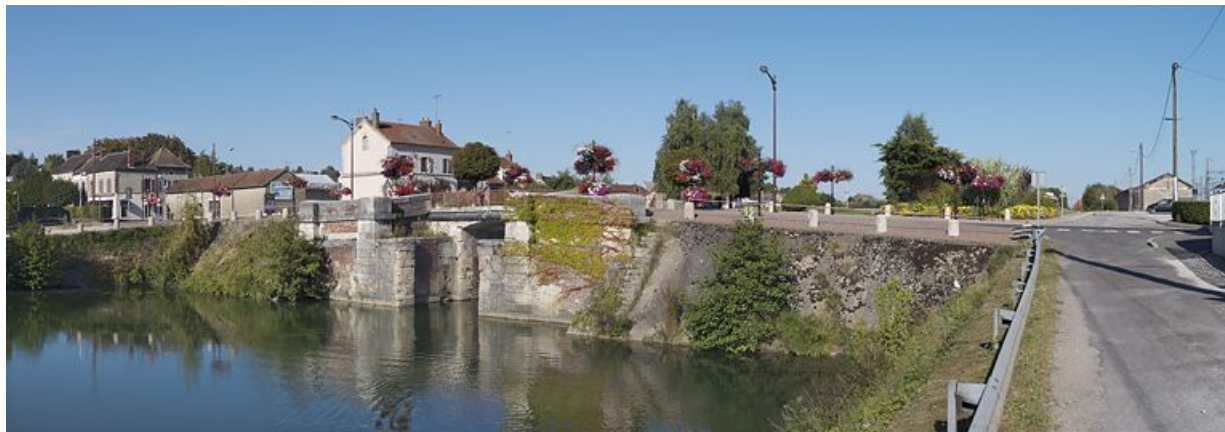
Le pont sur écluse en brique, vu de l'avant-port.
