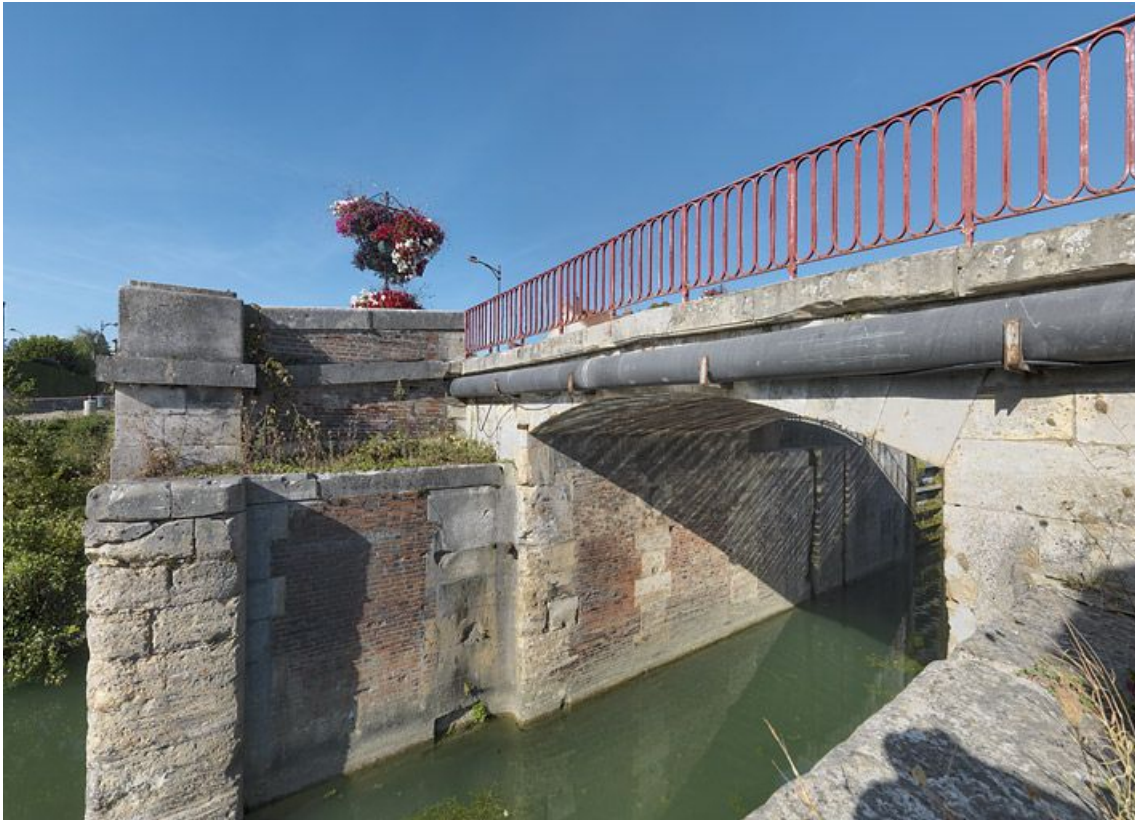
Le pont sur écluse : détail des maçonneries avec l'échelle de crues.
