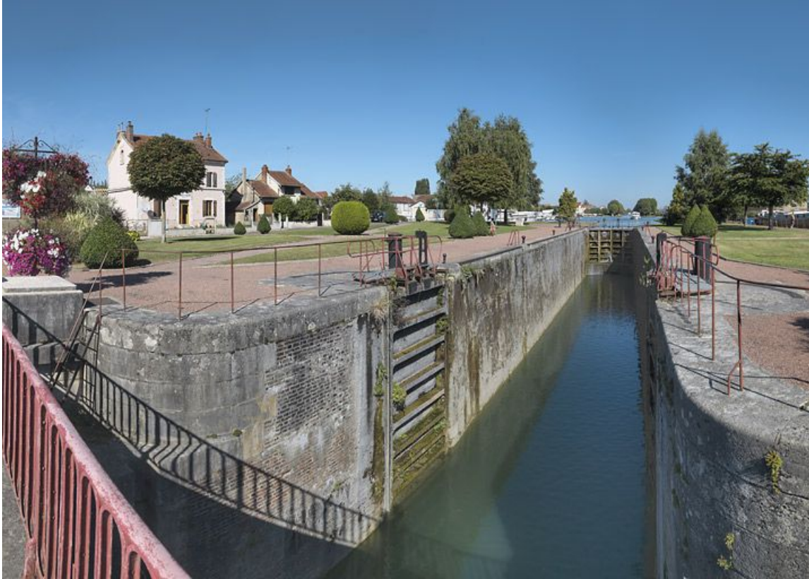
A Migennes, site de l'écluse 114-115 du versant Yonne, dite de Laroche, vu d'amont : portes et bajoyers.
