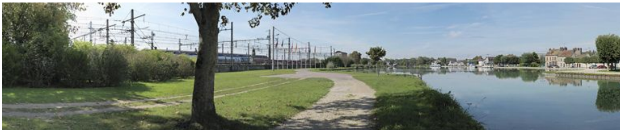
Vue d'ensemble du bassin prise d'amont : le site SNCF de Migennes est à droite de l'image, la ville de Migennes à gauche. 89, Migennes, lieudit : bief 114-115 du versant Yonne
