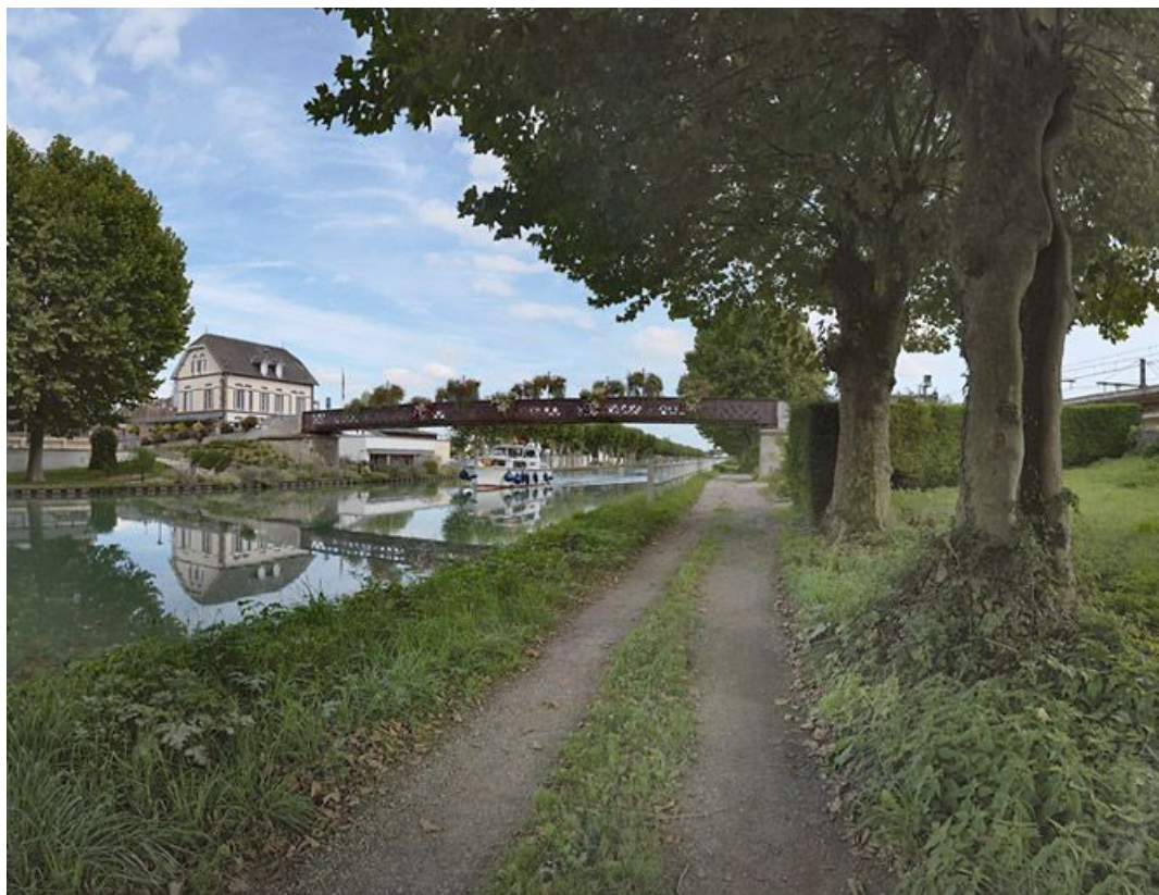
Vue d'ensemble prise d'aval, remarquez l'ancien hôtel à gauche (la gare est à droite, dans le prolongement direct de la passerelle). 89, Migennes, lieudit : bief 114-115 du versant Yonne
