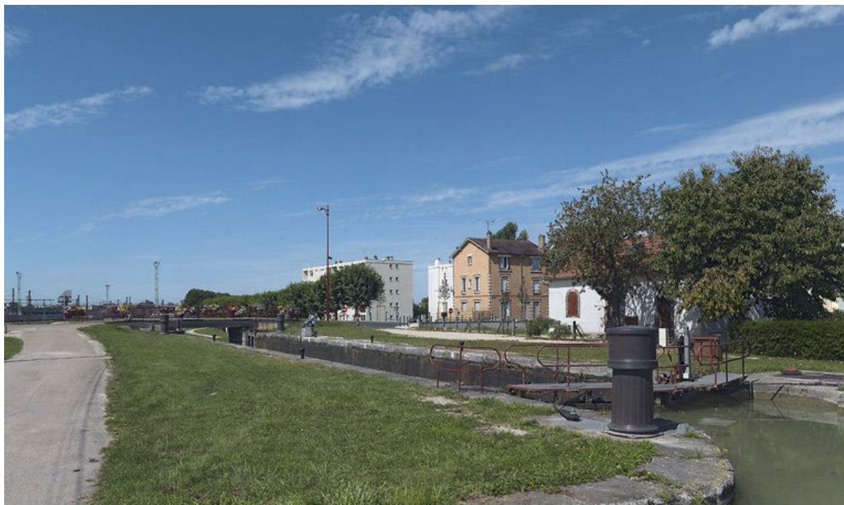
Vue d'ensemble prise d'amont. Site SNCF au fond à gauche.
