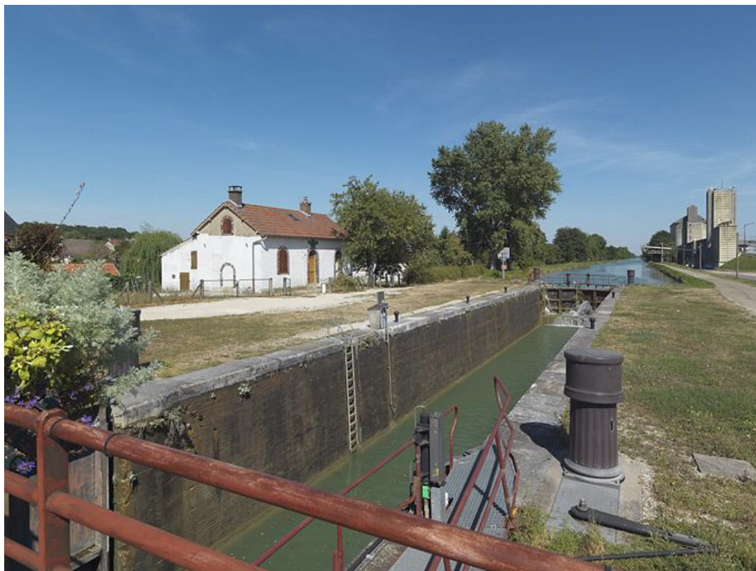
Panorama du site de l'écluse 113 du versant Yonne, dite de Cheny à Migennes, pris d'aval, du pont sur écluse. De gauche à droite : site d'écluse, silos. Le bief est vide : on voit la maçonnerie des bajoyers.
