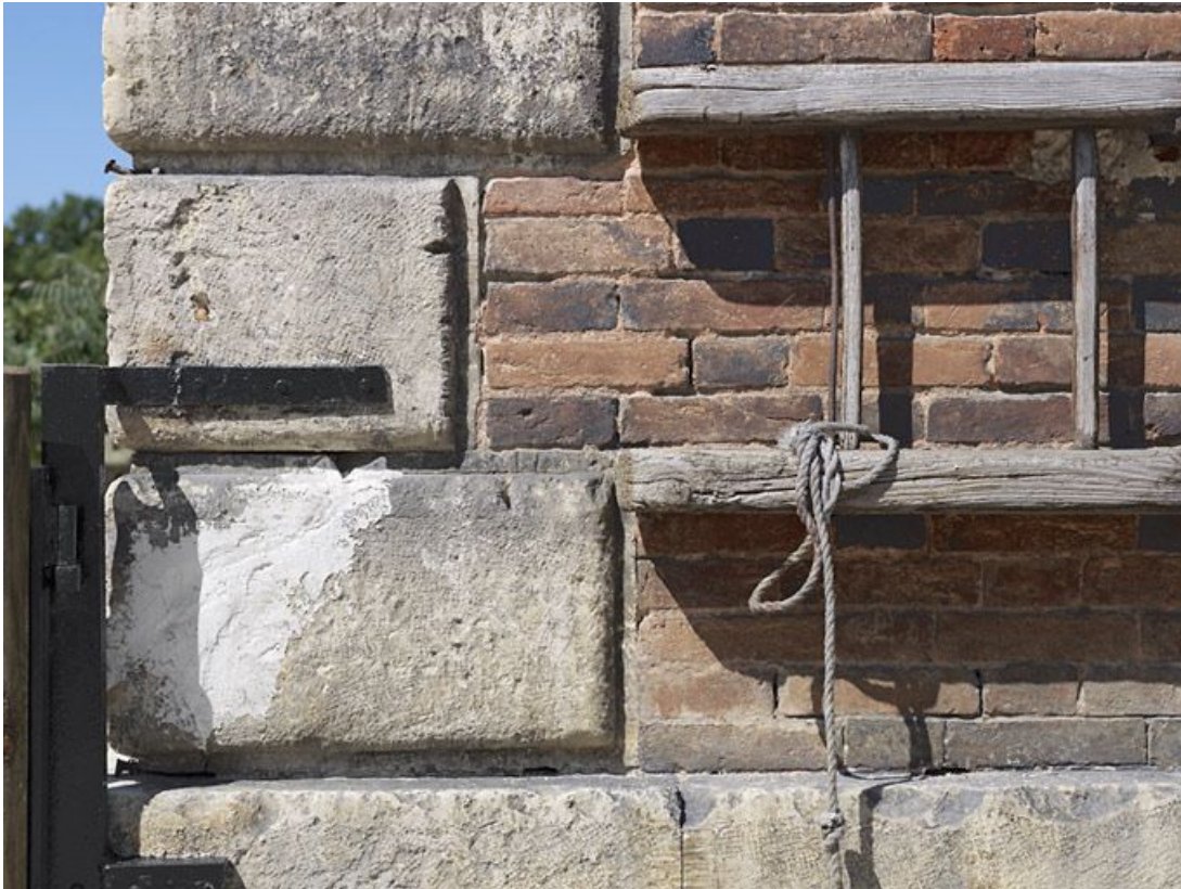
Maison éclusière : détail de la chaîne d'angle et de l'échelle fixée sur le côté.
