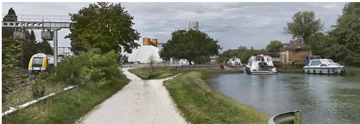
Vue d'ensemble de l'environnement du site d'écluse. De droite à gauche : la maison éclusière, le canal, un silo, la voie ferrée. 89, Brienon-sur-Armançon, lieudit : bief 111 du versant Yonne
