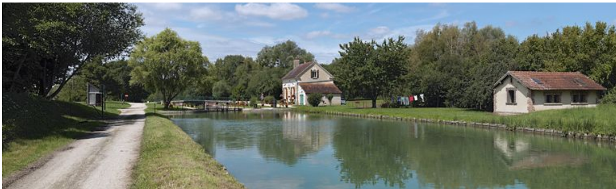
Vue d'ensemble prise d'amont, avec le lavoir à droite.
