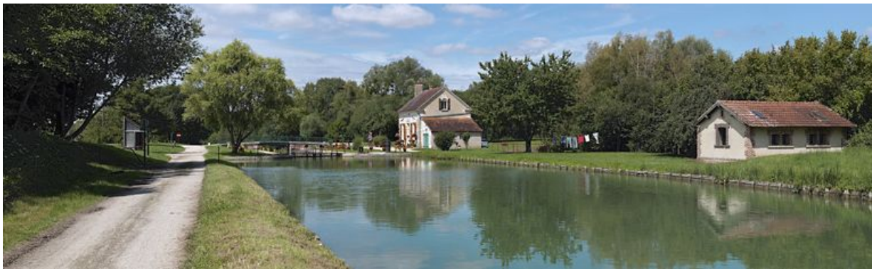
Vue d'ensemble prise d'amont, avec le lavoir à droite.
