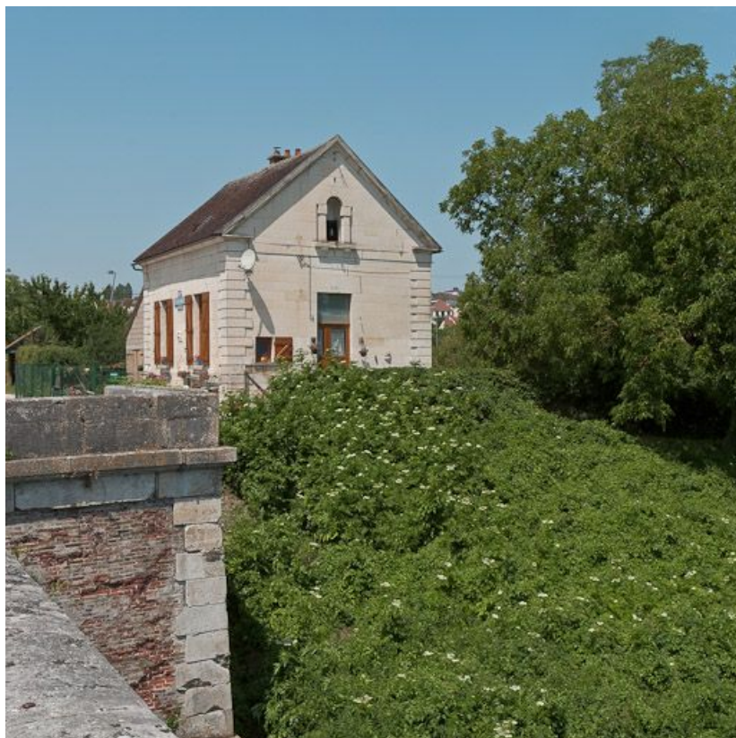
Vue de la façade latérale de la maison éclusière.
