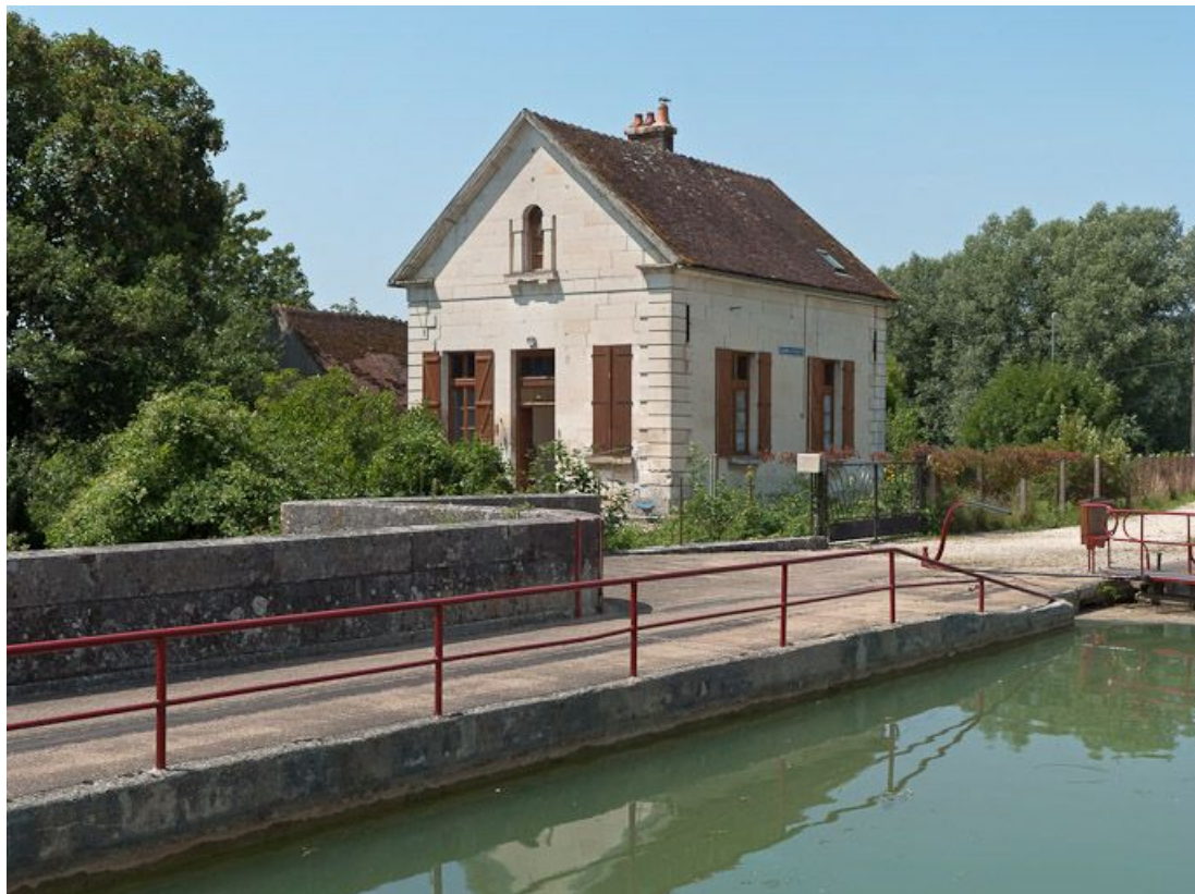
Vue de la maison de garde située en face de la maison éclusière.
