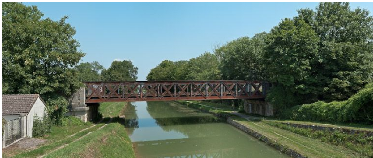
Vue du pont.
