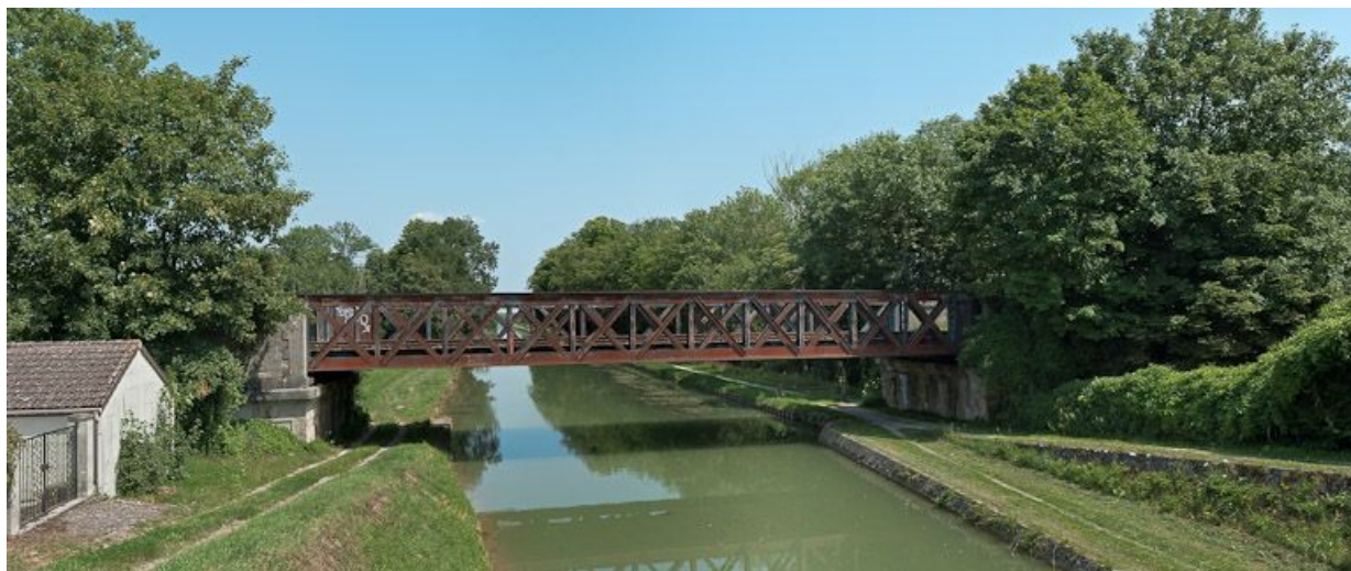
Vue du pont.
