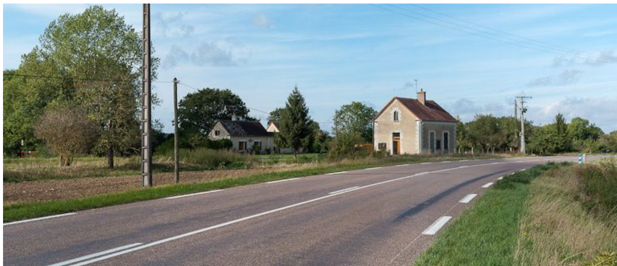
La maison éclusière vue depuis la route. On aperçoit l'ancienne maison de garde. 89, Percey, lieudit : bief 104 du versant Yonne
