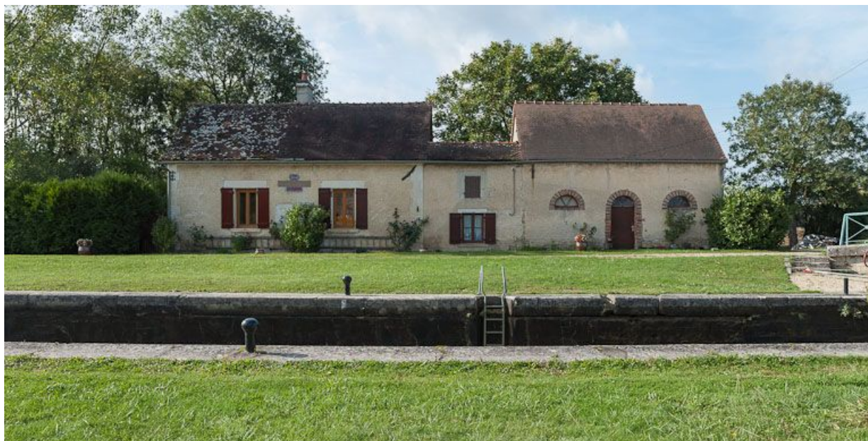
Vue de l'ancienne maison de garde, rive gauche, actuelle maison éclusière.
