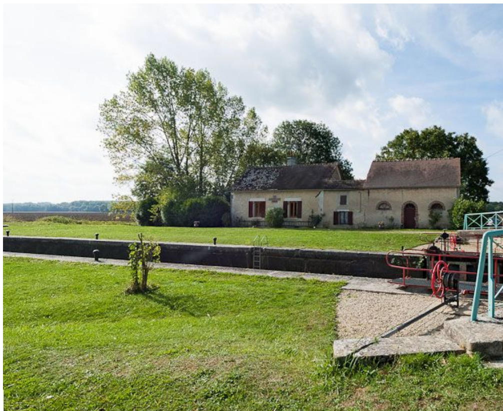
Vue de l'ancienne maison de garde, actuelle maison éclusière.
