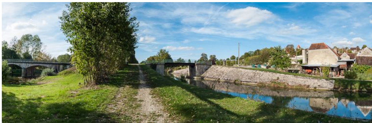
Vue d'ensemble du pont sur canal avec à gauche un pont sur l'Armançon.
