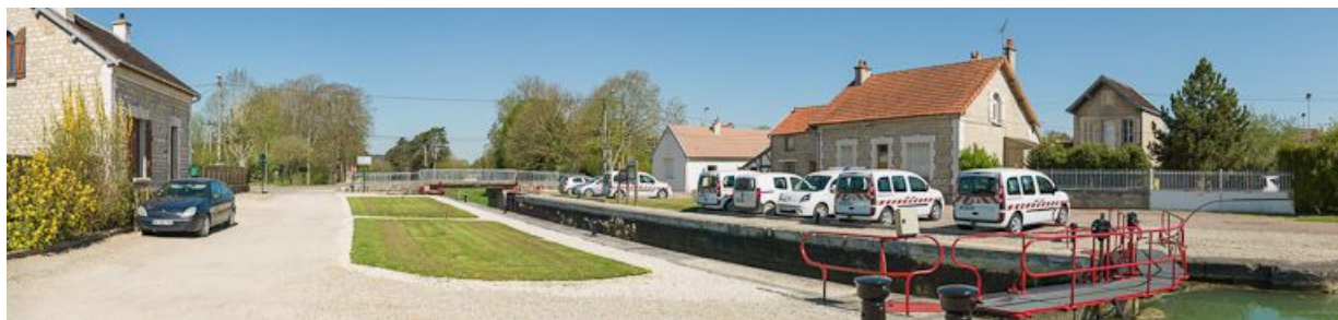
Vue d'ensemble du site d'écluse. Rive gauche, la maison éclusière, rive droite la subdivision de Tonnerre.
