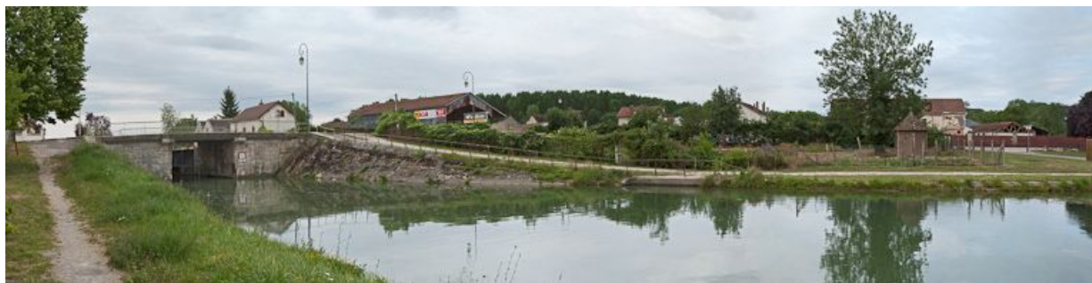
Vue du pont sur écluse et de l'arrivée de la rigole d'alimentation.
