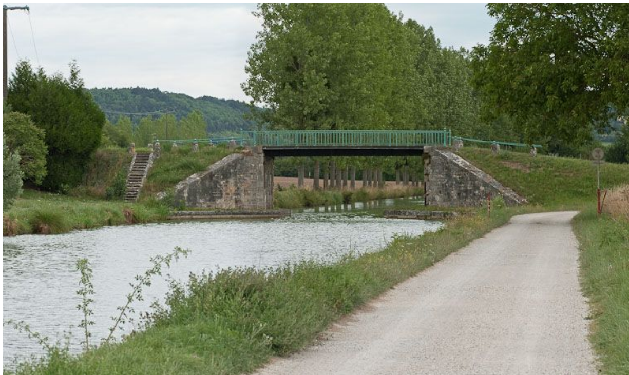
Vue du pont et de la rampe d'escalier à gauche.
